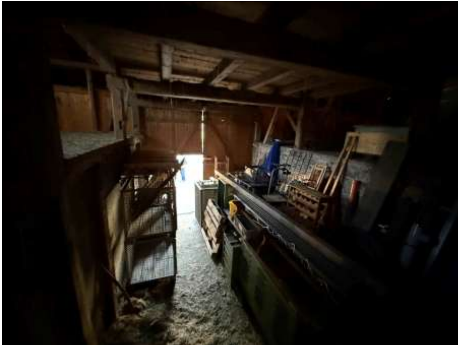
Bild 35: Ökonomiegebäude, Blick zum Tor
