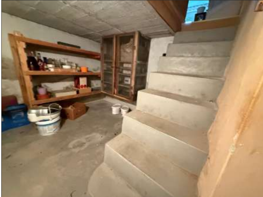
Bild 33: KG, Kellerraum, Kellertreppe
