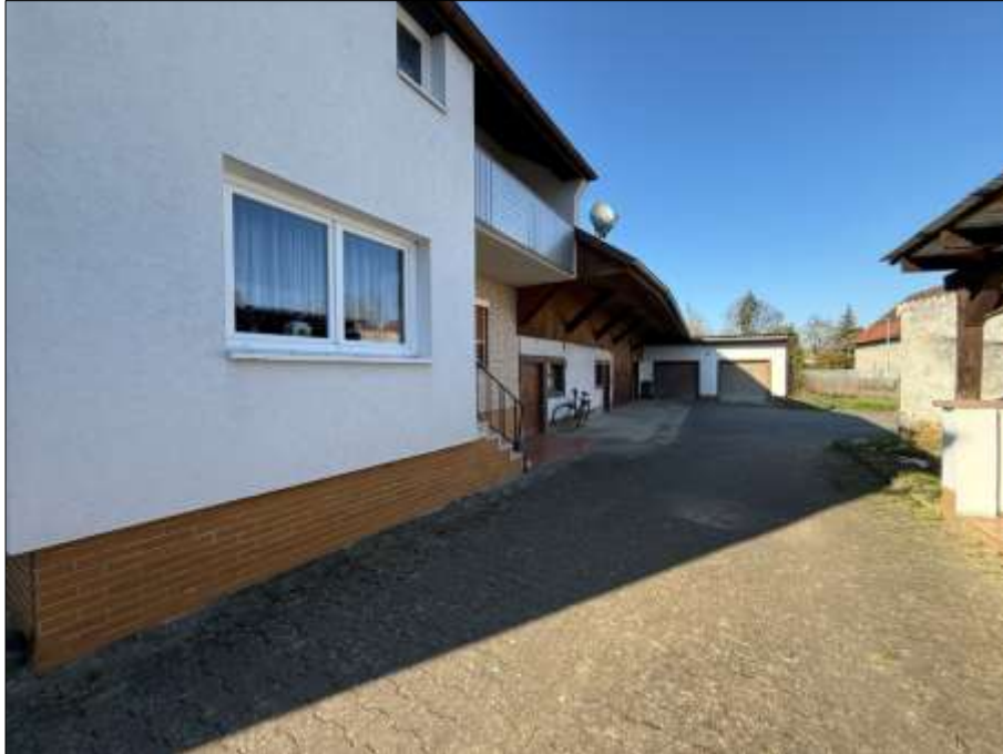
Bild 3: Wohnhaus mit Ökonomiegebäudeanbau und Garage
