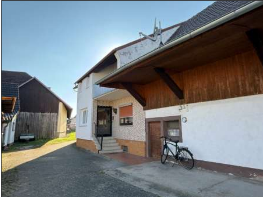
Bild 5: Blick zum Hauseingang
