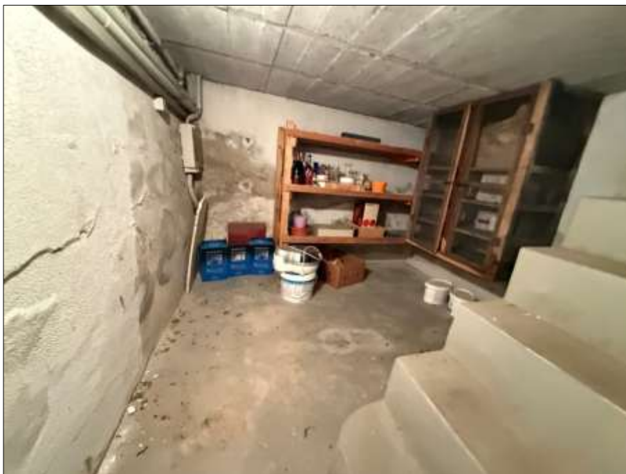
Bild 34: KG, Kellerraum, Kellertreppe
