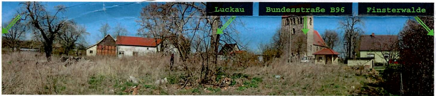
Gesamtsituation innerhalb des Grundstückes mit Blick zu der Straße und der Dorfkirche Riedebeck
