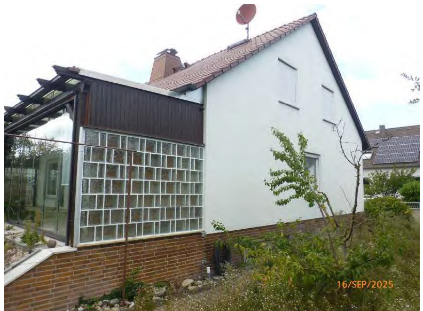
Ansicht von Süd-Osten
