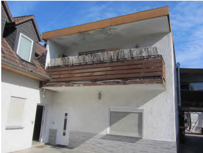
Bild 17: Gebäude 2, Ansicht Süd
