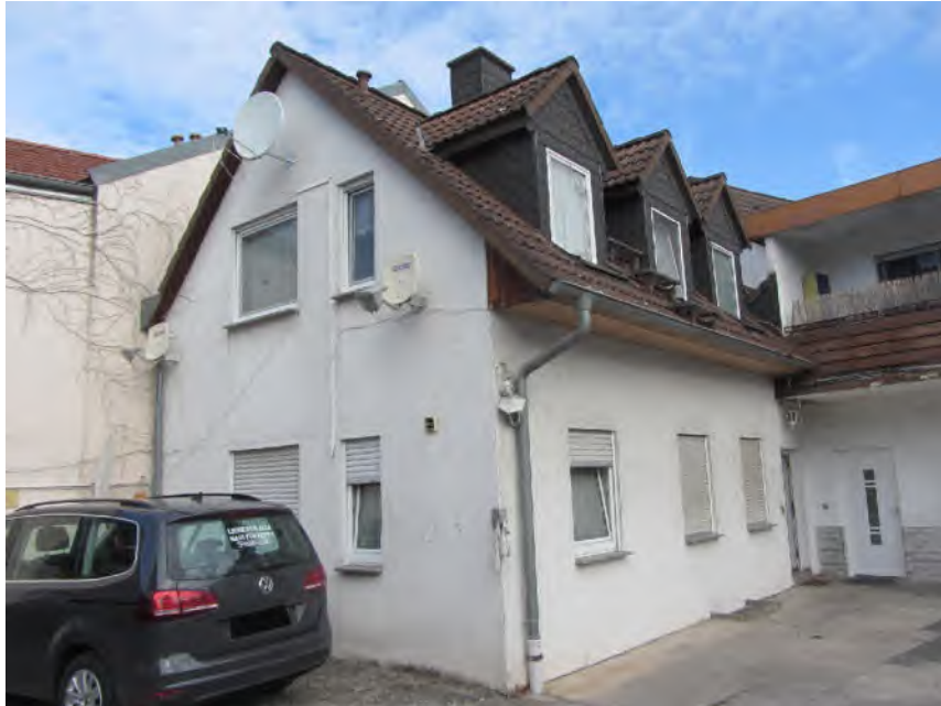
Bild 21: Gebäude 3, Ansicht Südost
