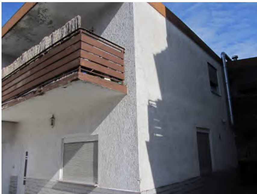
Bild 16: Gebäude 2, Ansicht Südost
