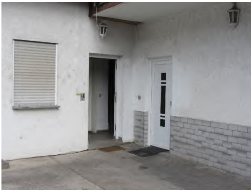
Bild 24: Gebäude 3, Eingangssituation (linke Tür)
