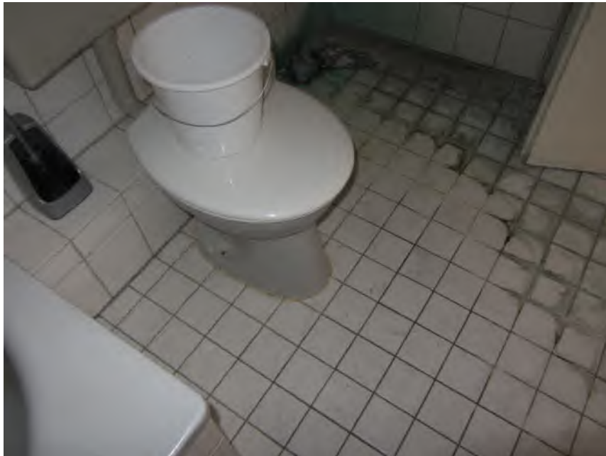
Bild 49: Gebäude 4, Whg. 3, DG, Bad
