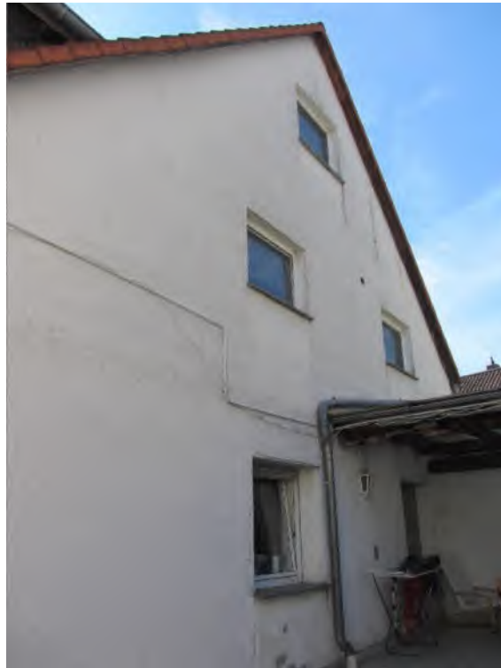
Bild 39: Gebäude 4, Ansicht West
