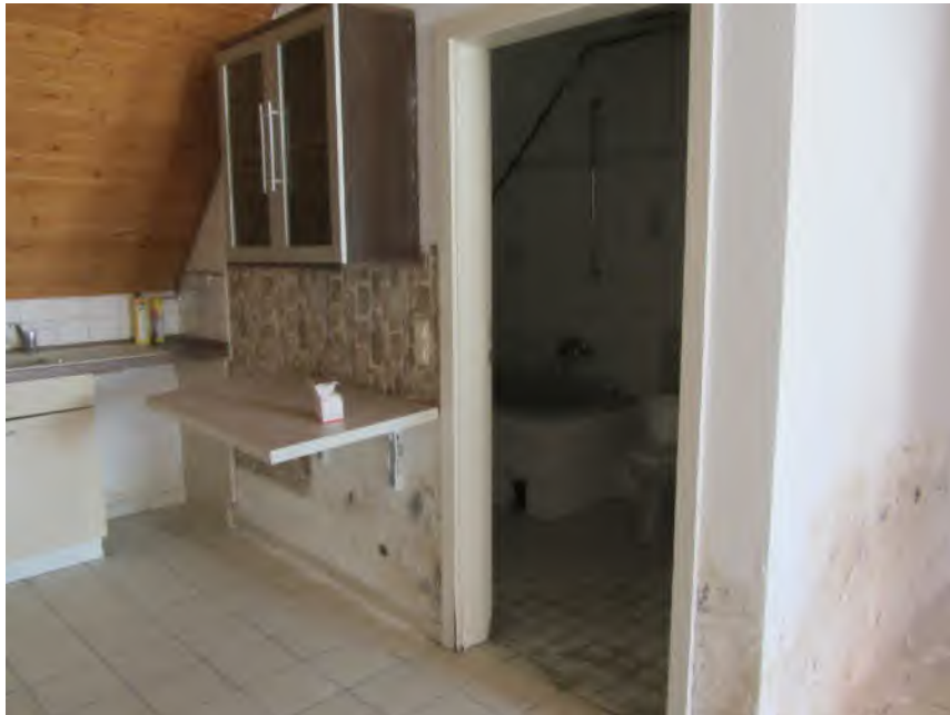
Bild 45: Gebäude 4, Whg. 3, DG, Zugang zu Bad
