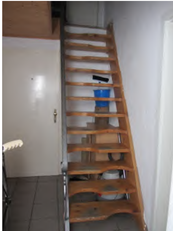
Bild 33: Gebäude 3, Treppenerschließung des DG von Gebäude 1
