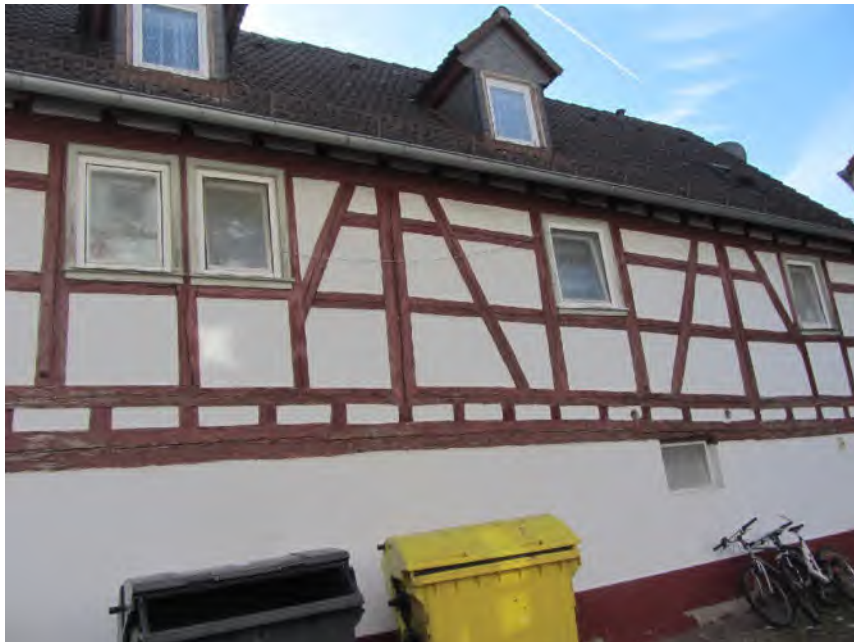
Bild 2: Gebäude 1, Ansicht West
