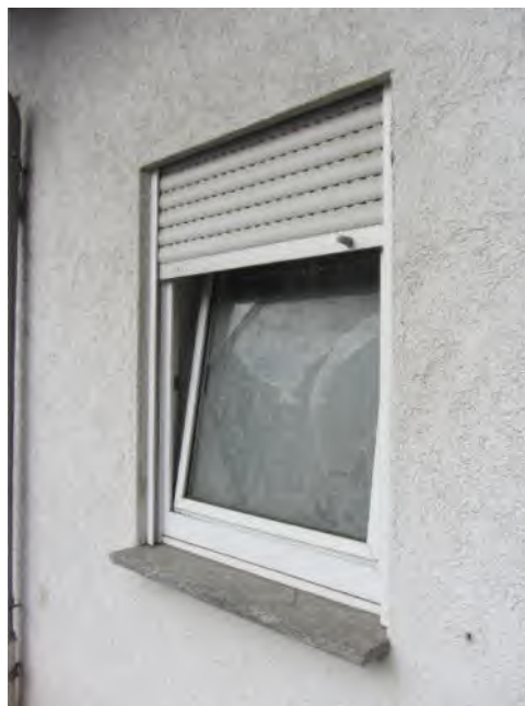
Bild 12: Gebäude 2, Zustand PVC-Fenster
