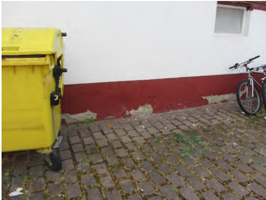
Bild 13: Gebäude 2, Zustand Sockelbereich
