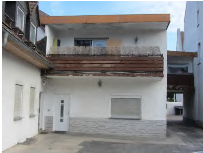
Bild 9: Gebäude 2, Ansicht Süd
