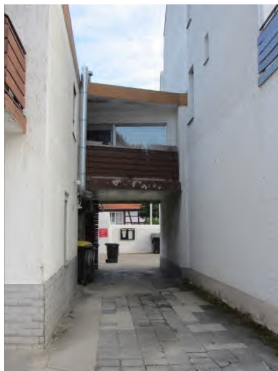
Bild 10: Gebäude 2, Ansicht Süd, Überbau Durchfahrt
