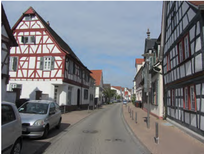
Bild 65: Nachbarbebauung im Straßenverlauf
