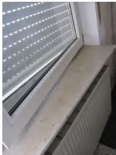
Bild 58: Gebäude 4, Whg. 1, EG, Zustand PVC-Fenster
