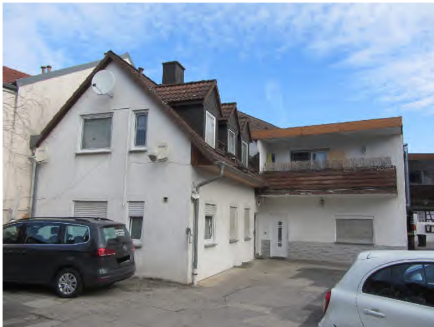
Bild 22: Gebäude 3, Ansicht Südost
