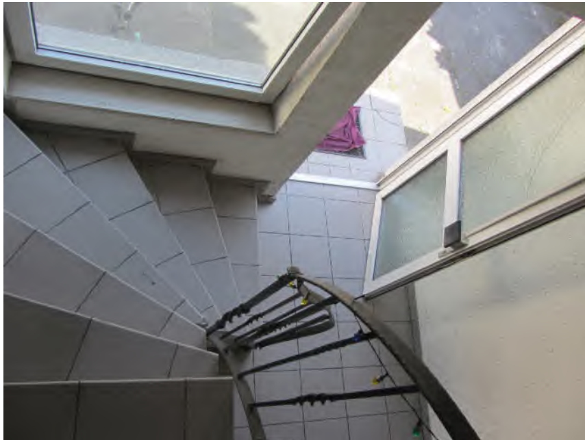
Bild 41: Gebäude 4, Flurbereich EG
