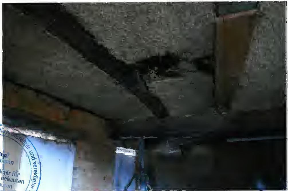
Bild 7: Blick in den Abstraum östlich der Durchfahrt: Deckenbalken prov. abgestützt - dringend statisch zu überprüfen!
