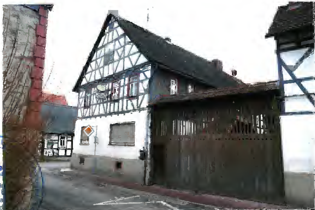
Bild 2: Blick von Nord-Westen auf die ehem. Gaststätte
