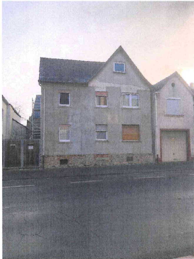
Bild 1 Wohnhaus, Straßenansicht von Westen
