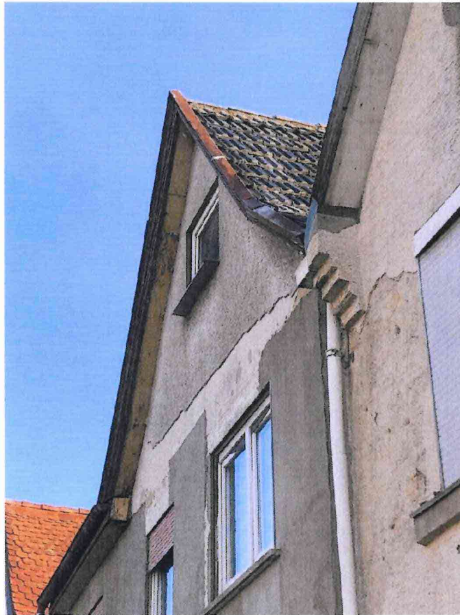
Bild 7 Putzschäden Fassade
