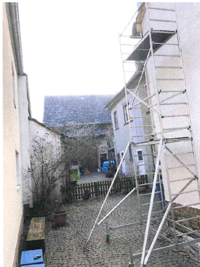
Bild 2 Hof von Nordwesten mit (von links) Anbau (2), Scheune, Anbau (1), Wohnhaus
