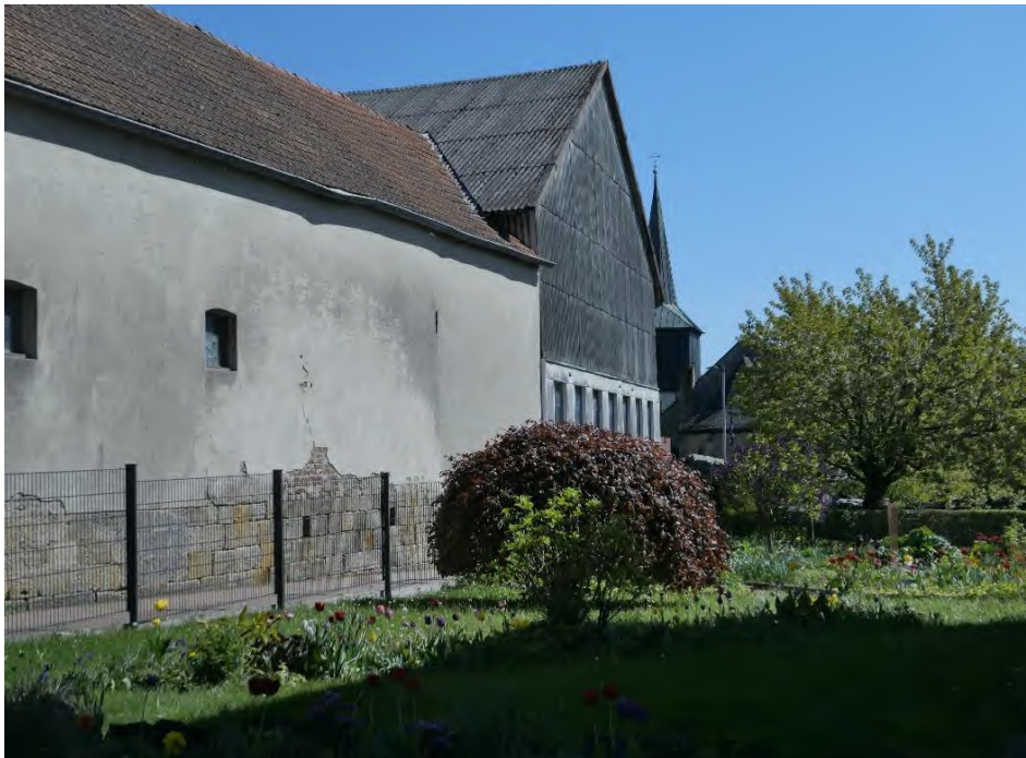
Nebengebäude Blickrichtung ost
