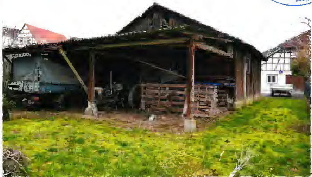
Bild 4: Blick von Osten auf die Scheune, im Vordergrund Unterstand
