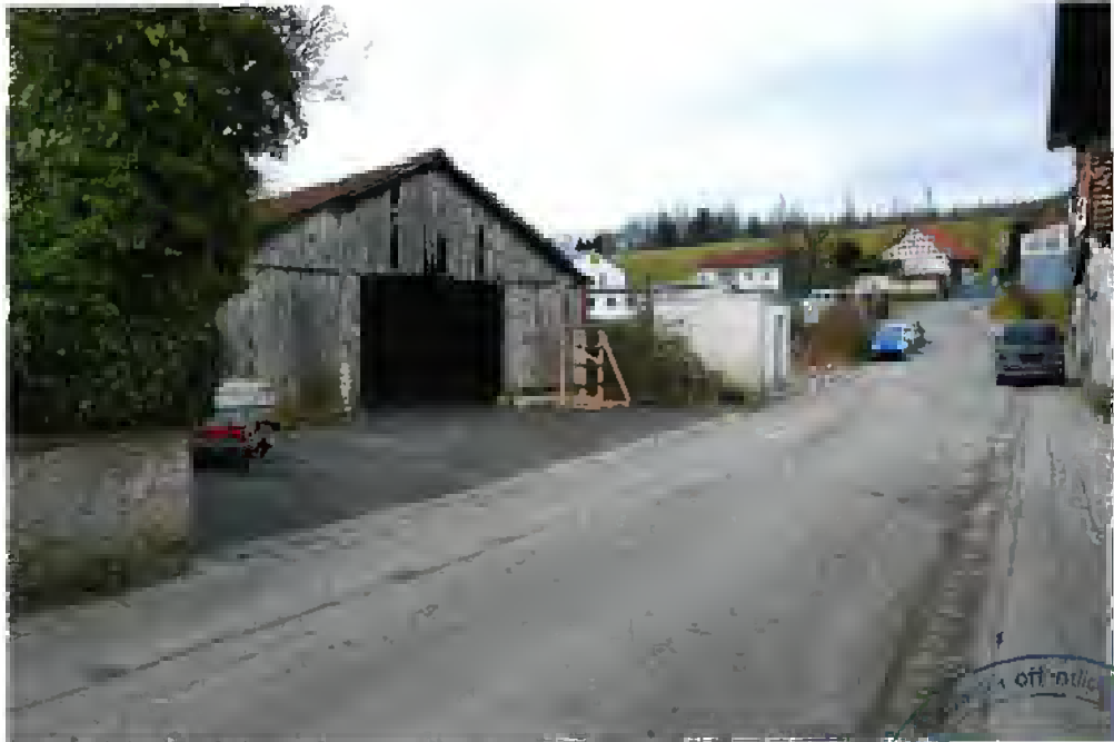
Bild 1: Blick von Nord-Westen auf die Scheune
