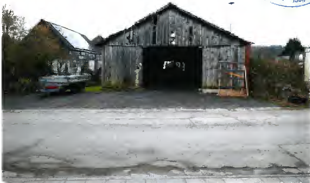
Bild 2: Blick von Westen auf die Scheune
