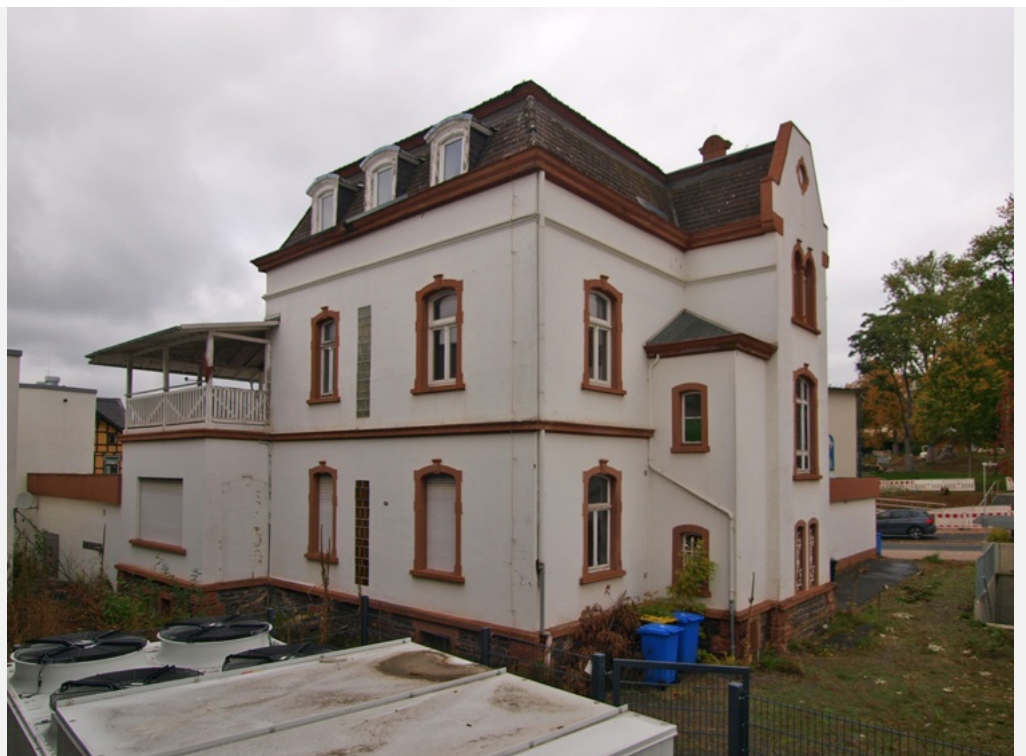
Ansicht des ehemalg als Wohn- und Geschäftshaus genutzten Gebäudes von Süden
