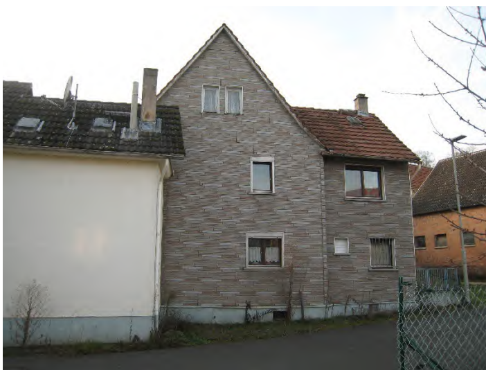
Bild Nr. 27, Seitenansicht DHH mit südl. Nebengebäude.
