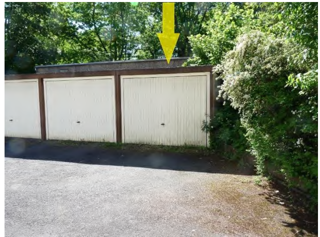
Foto 2 – Blick von der privaten Verkehrsfläche auf die Reihengaragen mit Kennzeichnung der zu bewertenden Garage
