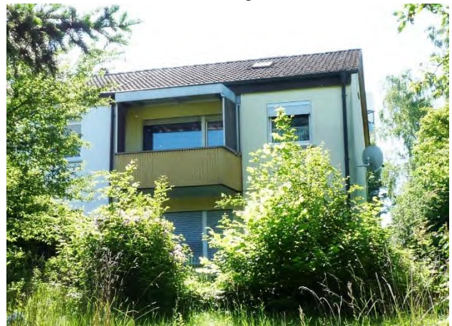
Foto 5 – Blick vom Garten auf die Nordwestfassade
