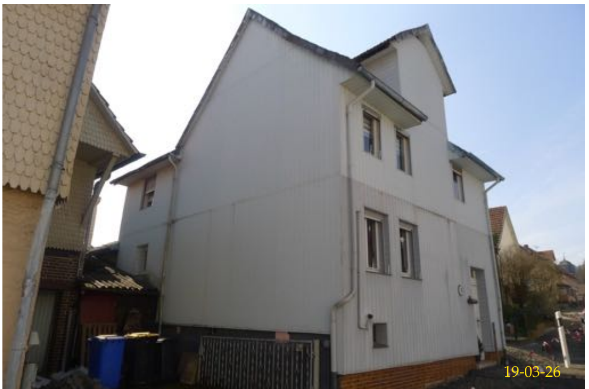
Straßenansicht von Norden
