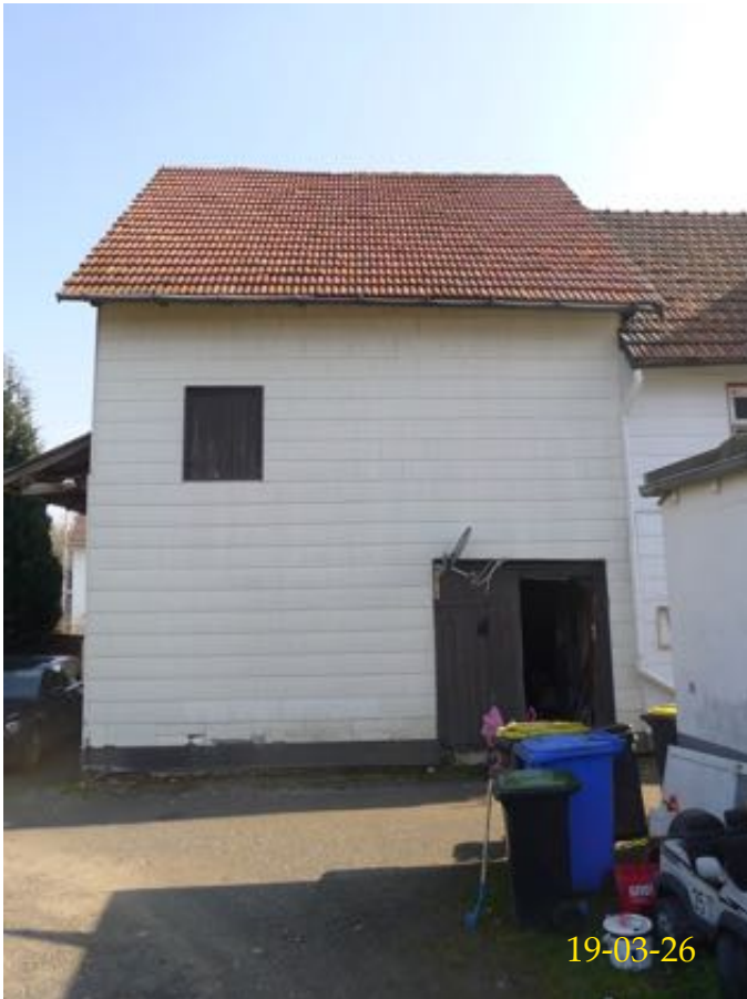
Fassade Scheune von Westen
