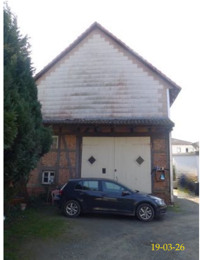
Giebel Fassade von Norden
