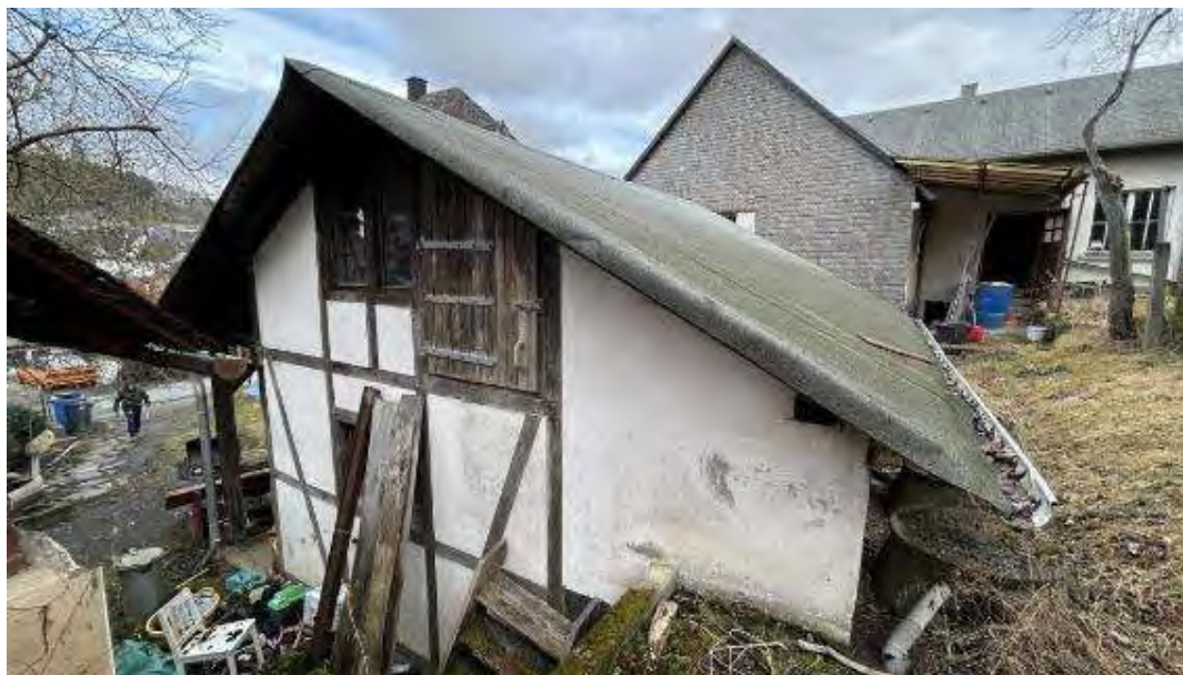
Bild B10 Nebengebäude
