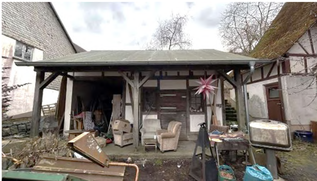
Bild B8 Nebengebäude
