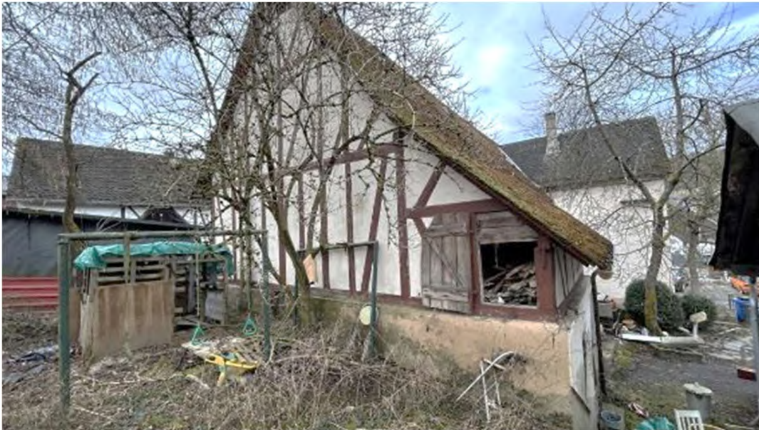
Bild B7 Scheune
