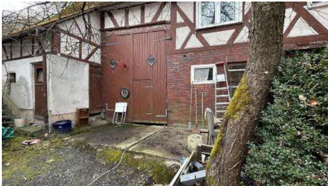
Bild B6 Scheune
