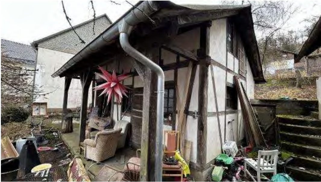
Bild B9 Nebengebäude
