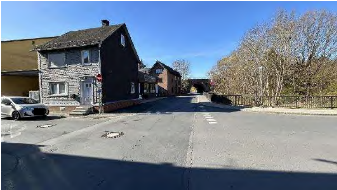
Bild A1 Blick in die Erschließungsstraße
