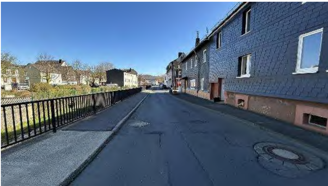
Bild A2 Blick in die Erschließungsstraße
