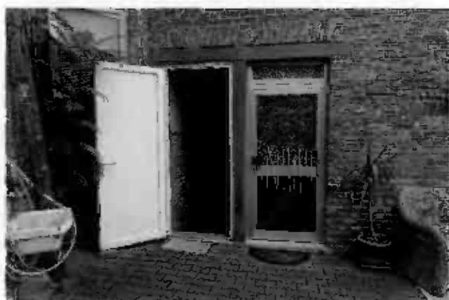
7.1.12 Hauseingang zum Vorderhaus, Kellereingang, Blick vom Hof Richtung Osten
