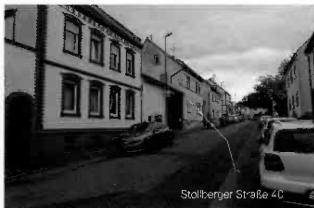
7.1.2 Straßenansicht, Blick von Süden Richtung Norden
