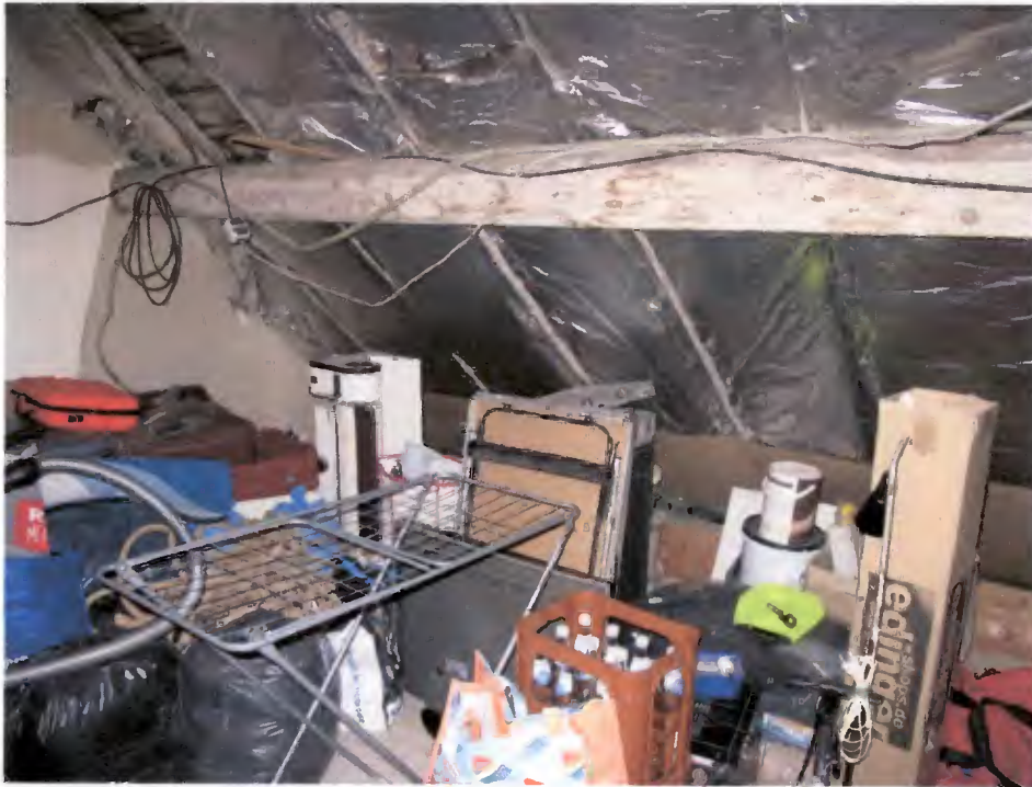
Foto Nr. 27: DG, Dachboden
