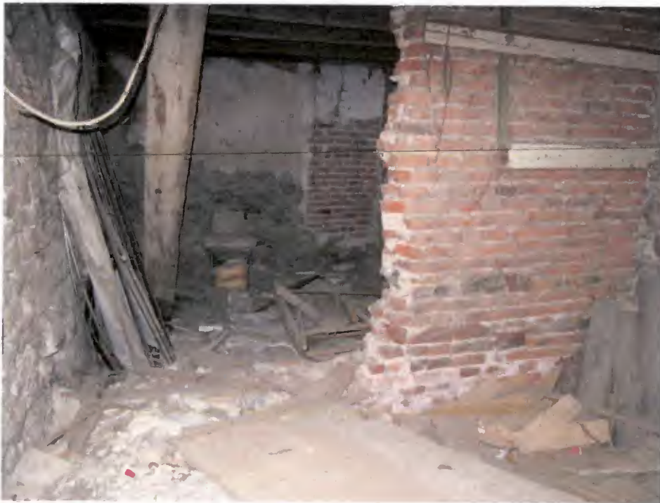
Foto Nr. 10: Nebengebäude, Innenansicht
