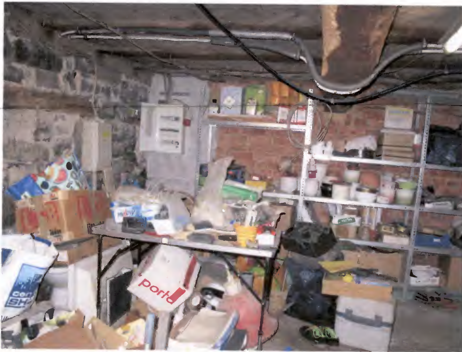
Foto Nr. 12: KG, Abstellraum
