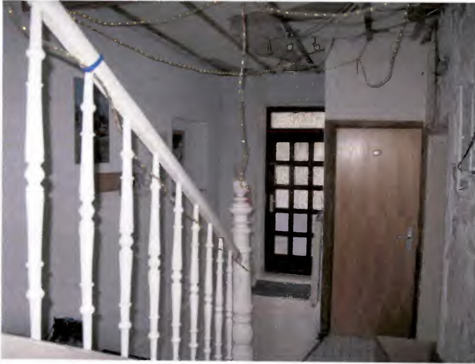
Foto Nr. 11: EG, Eingangsbereich mit Treppenhaus
