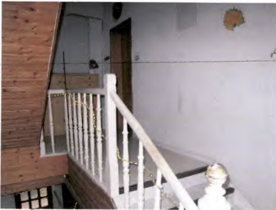
Foto Nr. 20: OG, Treppenhaus
