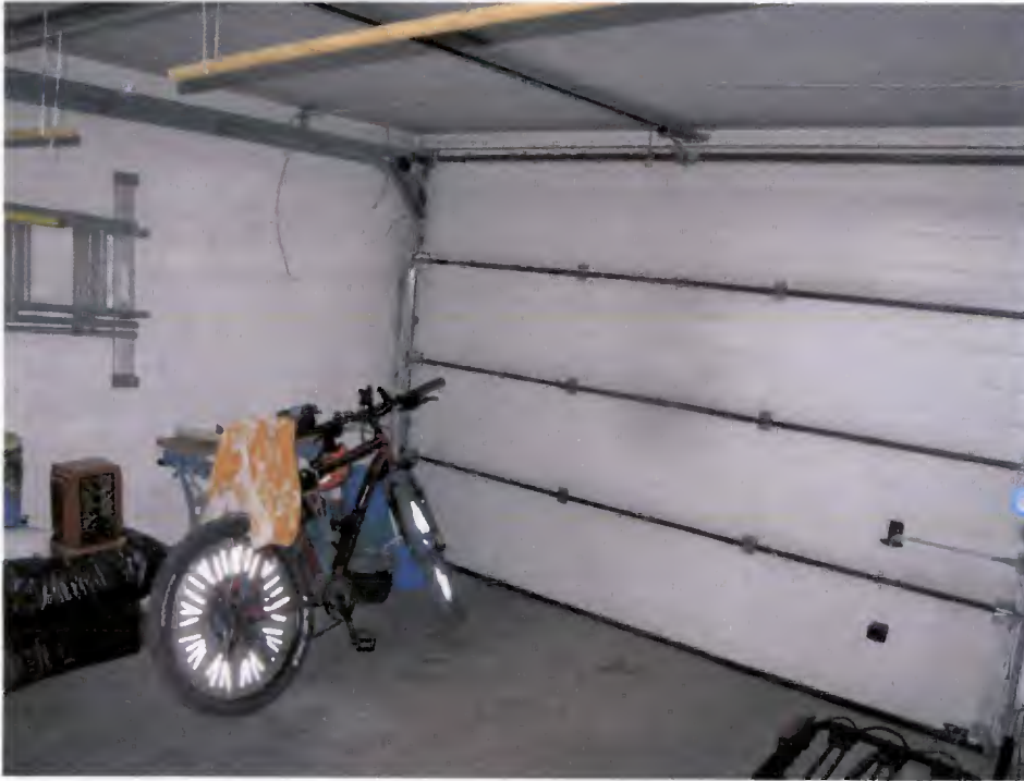
Foto Nr. 15: KG, Garage
