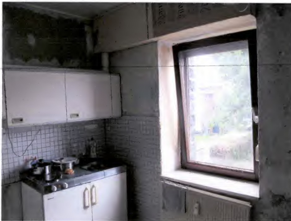
Foto Nr. 22: OG, Küche
