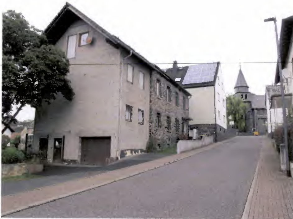
Foto Nr. 06: Verlauf Lahrer Weg Blickrichtung Norden mit Objekt (links)
