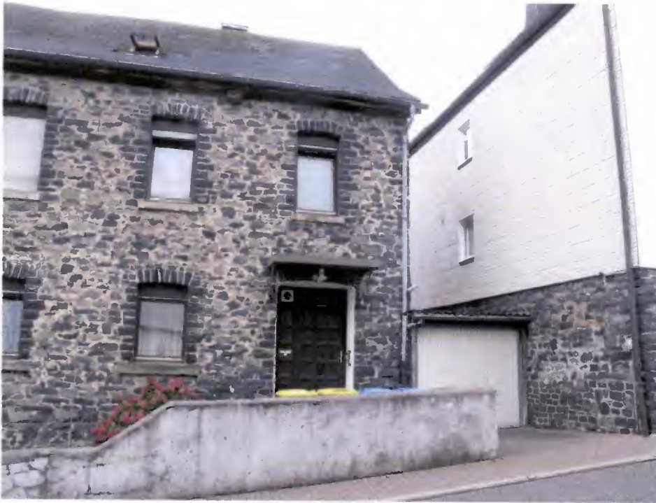
Foto Nr. 03: Ansicht von Lahrer Weg Blickrichtung Westen
