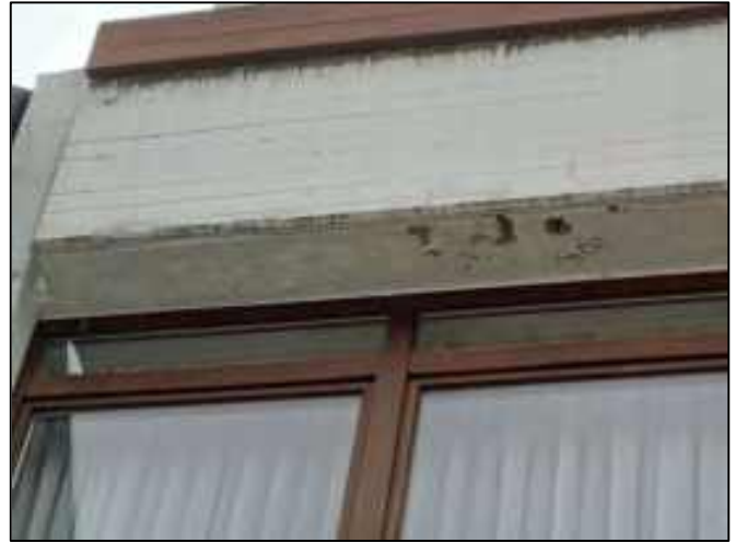
Abb. 35: Feuchteschäden Fassade
