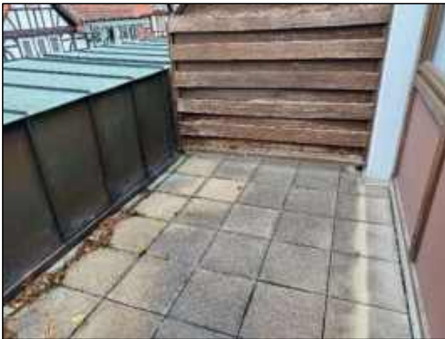
Abb. 36: Altbau 2. OG, Balkon
