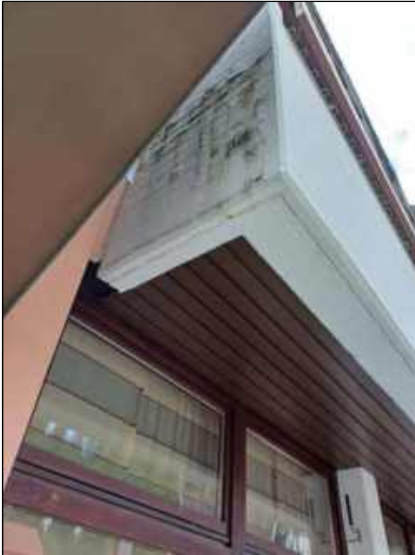
Abb. 34: Feuchteschäden Fassade
