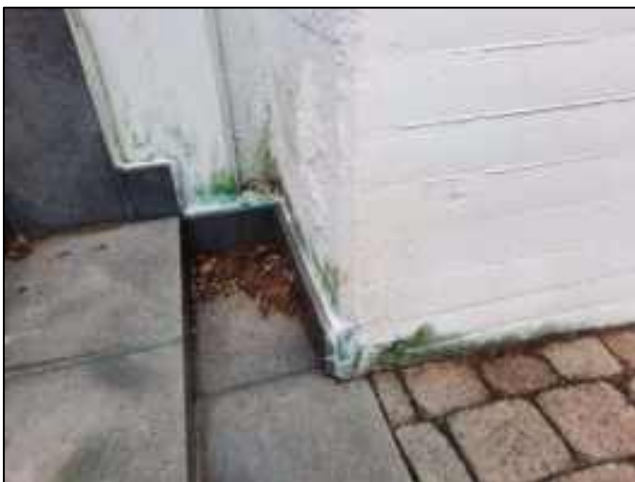
Abb. 32: Feuchteschäden Fassade
