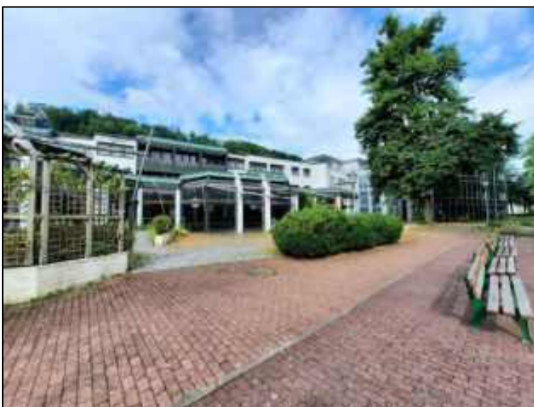
Abb. 6: Ansicht von Kurpark, Ostseite
