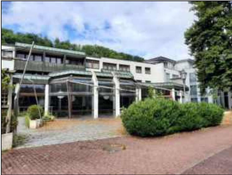
Abb. 7: Ansicht von Kurpark, Ostseite
