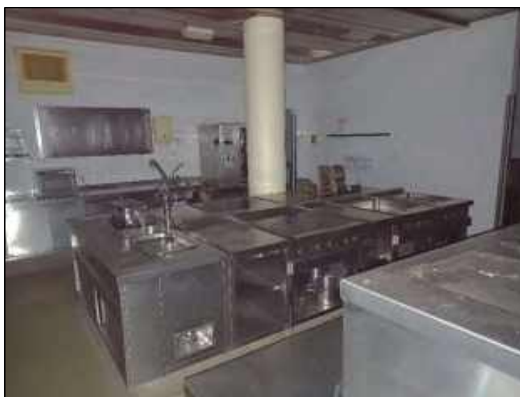
Abb. 18: Erdgeschoß Küche (Teilbereich)
