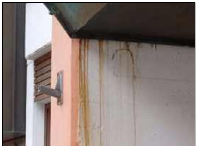
Abb. 33: Feuchteschäden Fassade
