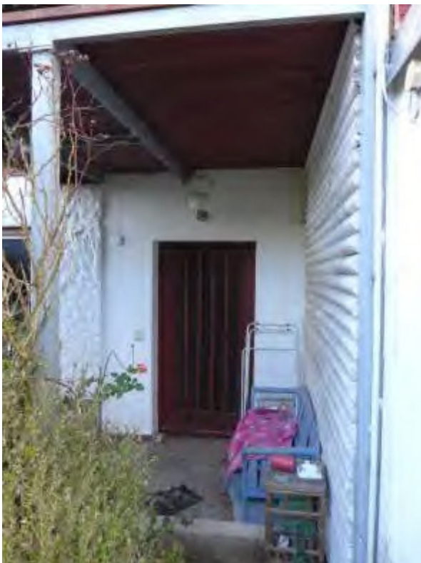
12 a Eingangsbereich EG
