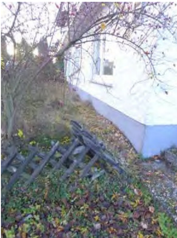
20 a Zustand Zaun am Eingangsbereich
