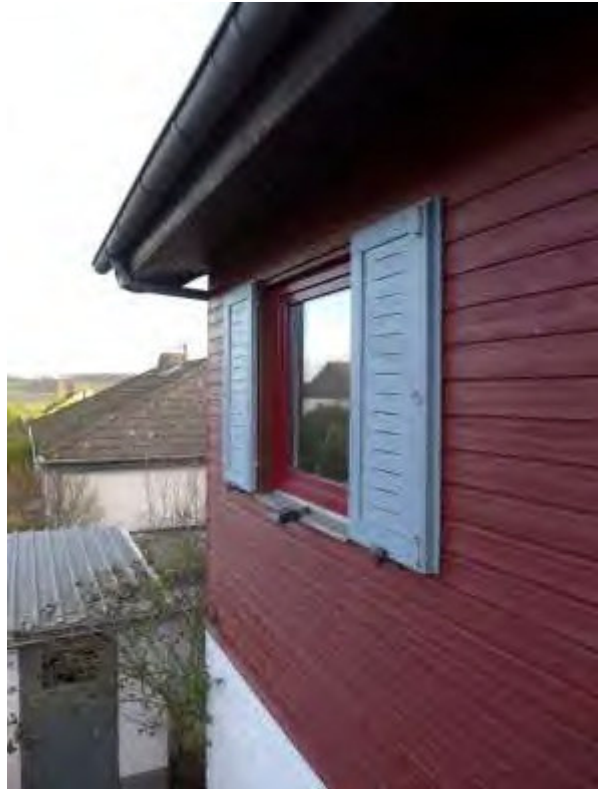
23 b Fassade Nordseite
