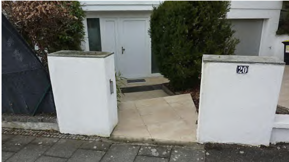
Hauszugang mit Haustür
