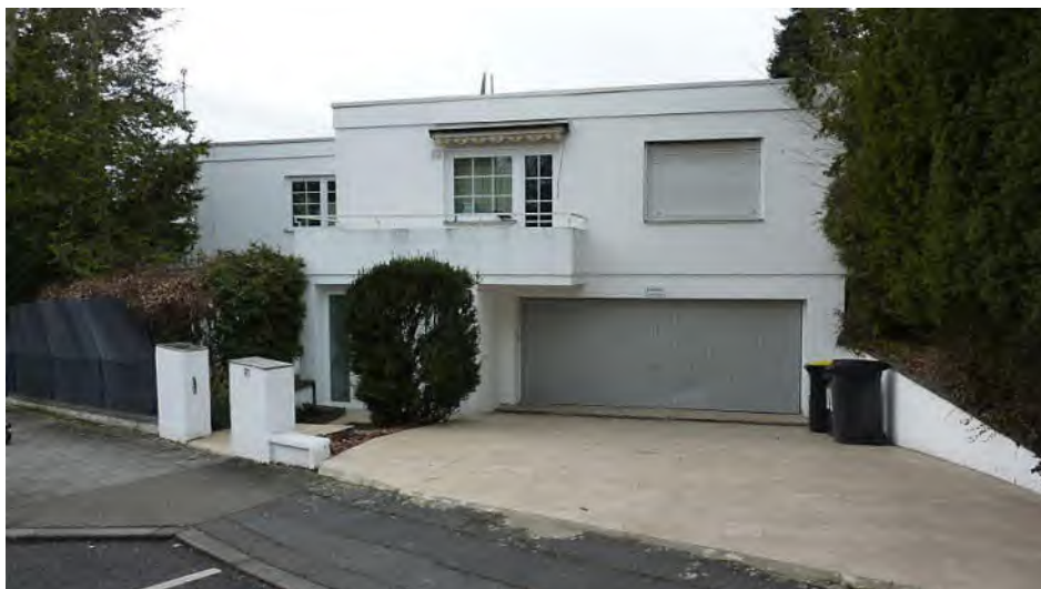
Gebäudeansicht mit Hauszugang und integrierter Doppelgarage
