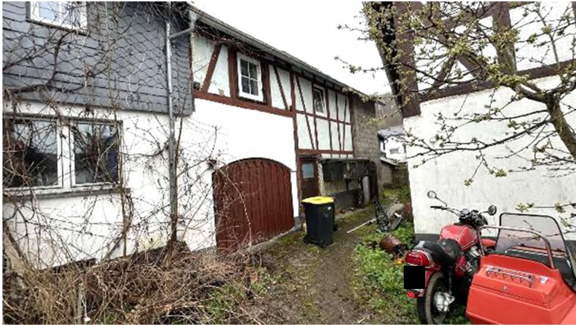
Bild B4 Scheune
