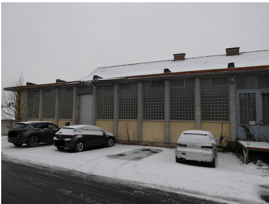
Nordansicht Geb. Teil 3
