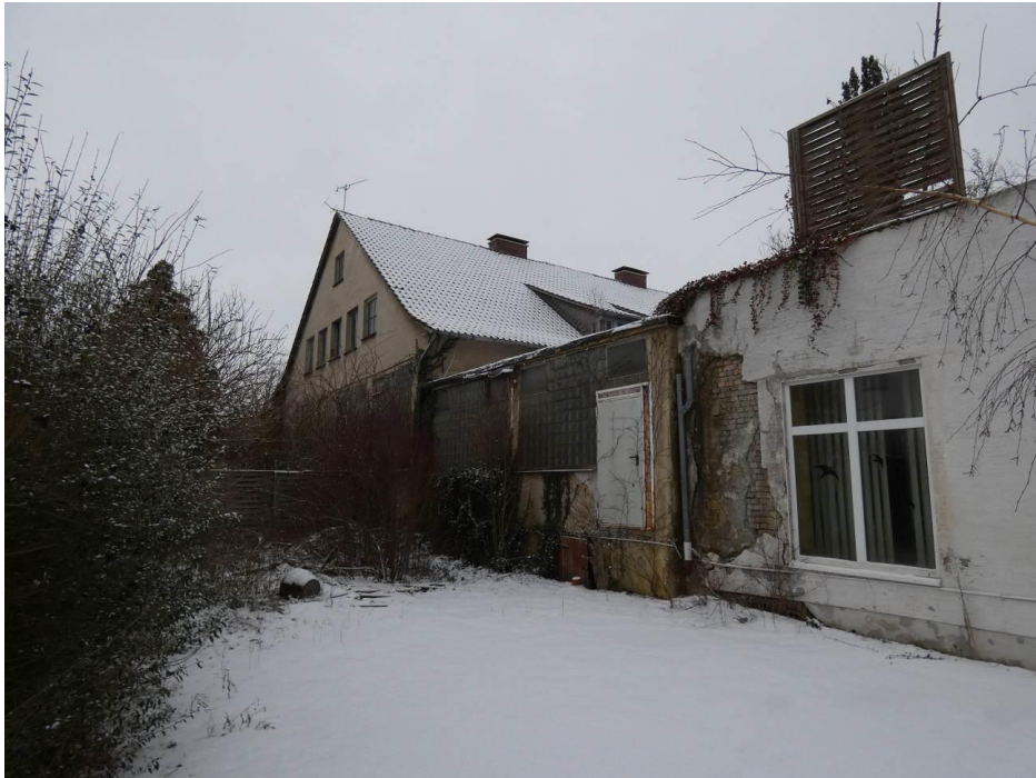
Süd – Westansicht Geb. Teil 2
