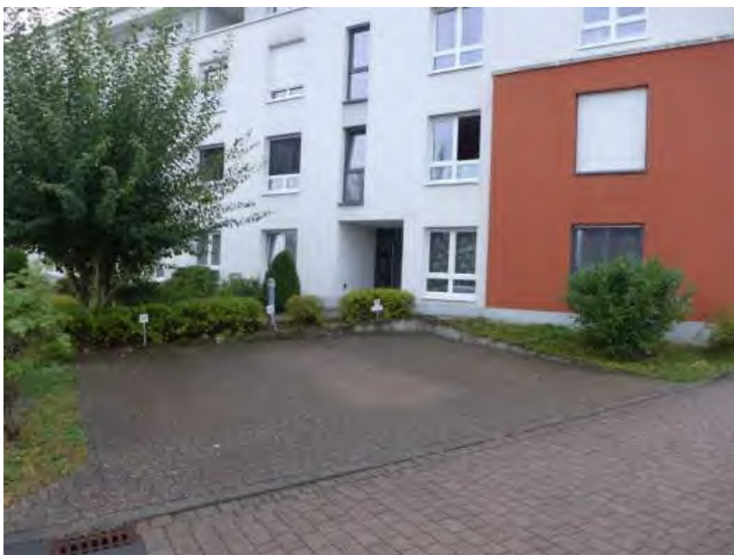
6 Stellplatzfläche (belegt mit Sondernutzungsrechten)
