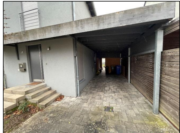
Carport mit Fahrradschuppen (hinten)
