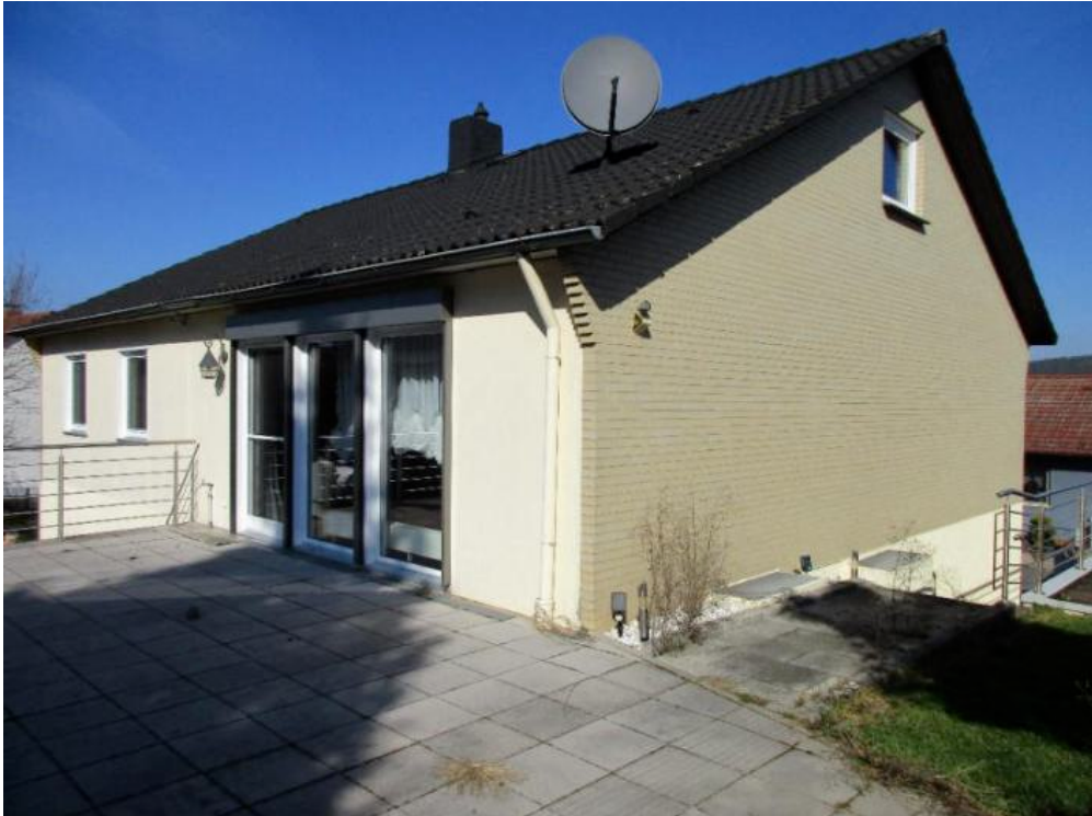
Rückwärtige Ansicht des Objektes
