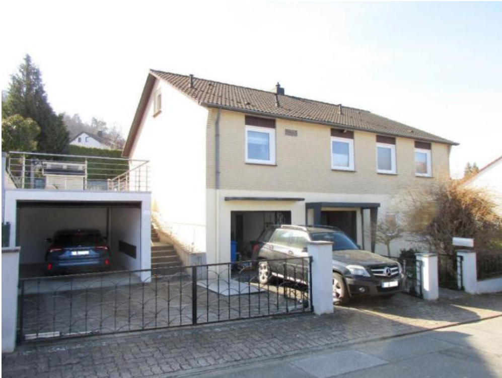
Blick auf das Wohnhaus von der Straße aus
