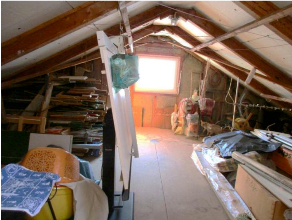
Dachspeicher (nicht ausgebauter Teil)
