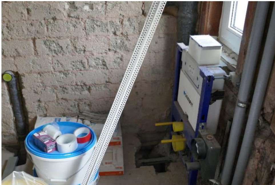
Bild 7: Detailaufnahme Wohnung Nr. 1 (Kernsanierung in Vorbereitung)
