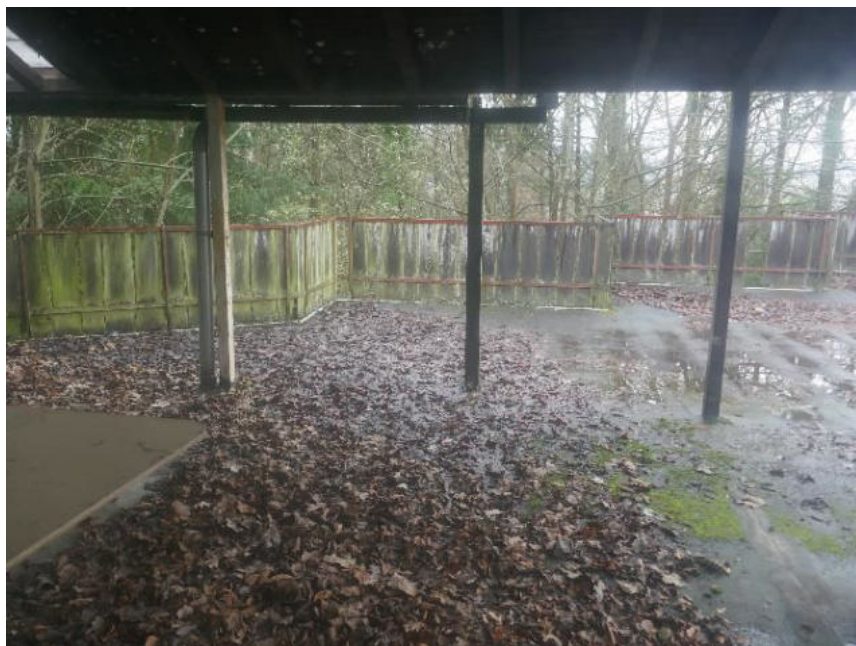
Bild 6: Flachdach des Anbaus (ehemalige Gastronomie)
