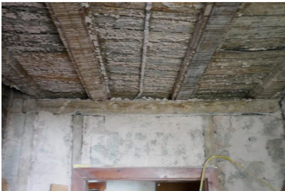
Bild 8: Detailaufnahme Wohnung Nr. 1 (Kernsanierung on Vorbereitung)
