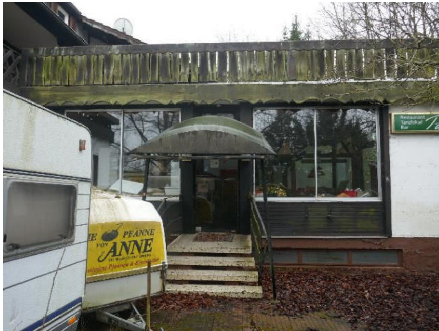
Bild 15: Zugang zum Anbau
