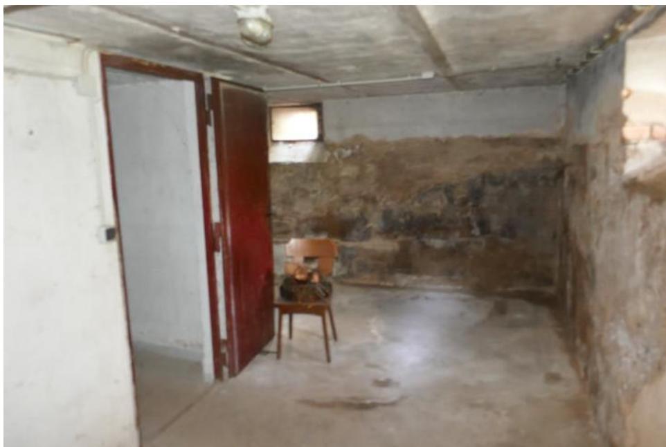
Bild 10: Kellerräume im Altbau
