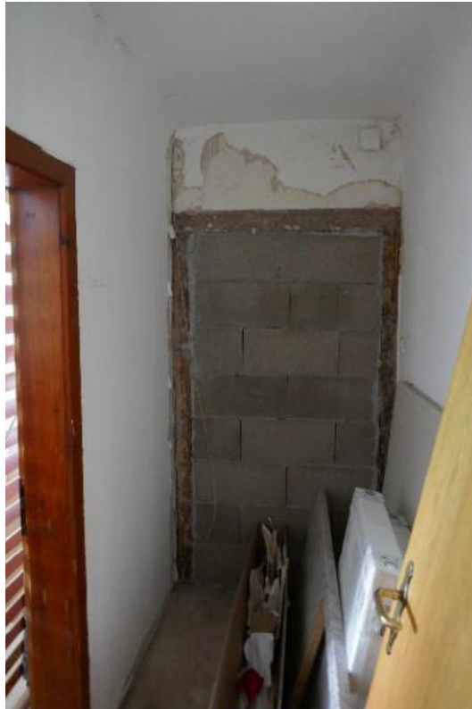
Bild 9: Flur in Wohnung Nr. 1 mit zugemauertem Übergang zu Wohnung Nr. 4
