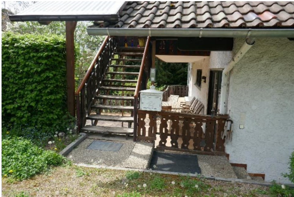
Bild 3: Zugangstreppe zum DG-Balkon (Seiteneingang zu Wohnung Nr. 5) (Archivbild 2021)
