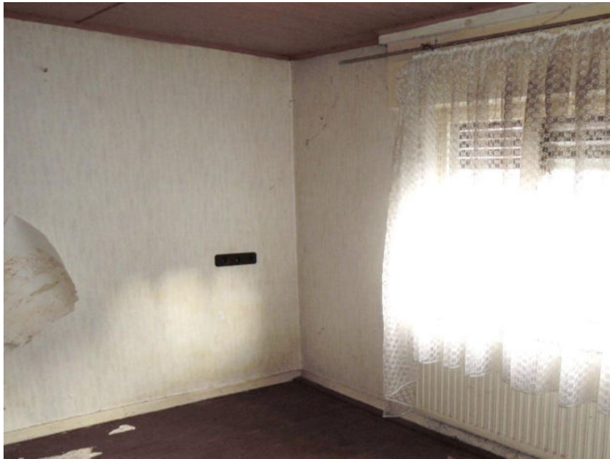
Bild 13: Zimmer im Obergeschoss
