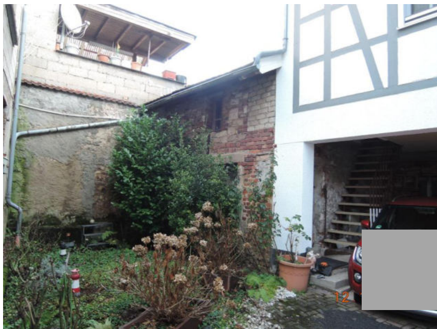
Bild 22: Schuppen und Pkw-Abstellplatz im Erdgeschoss des Neubaus
