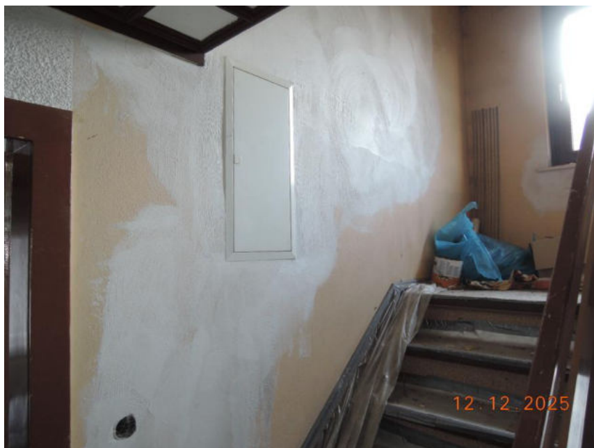
Bild 12: Treppe zum Dachgeschoss
