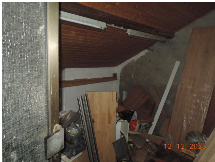
Bild 24: Dachgeschoss des Schuppens
