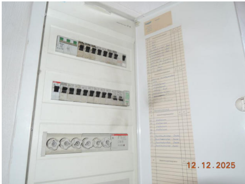
Bild 15: modernisierter Sicherungskasten im Obergeschoss
