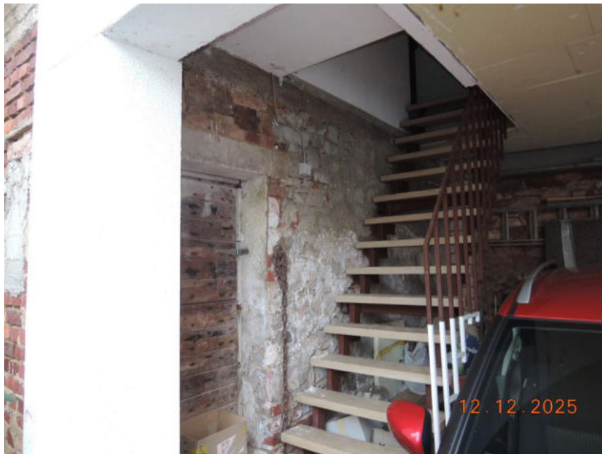
Bild 23: Treppe zum Dachgeschoss des Schuppens bzw. des Neubaus
