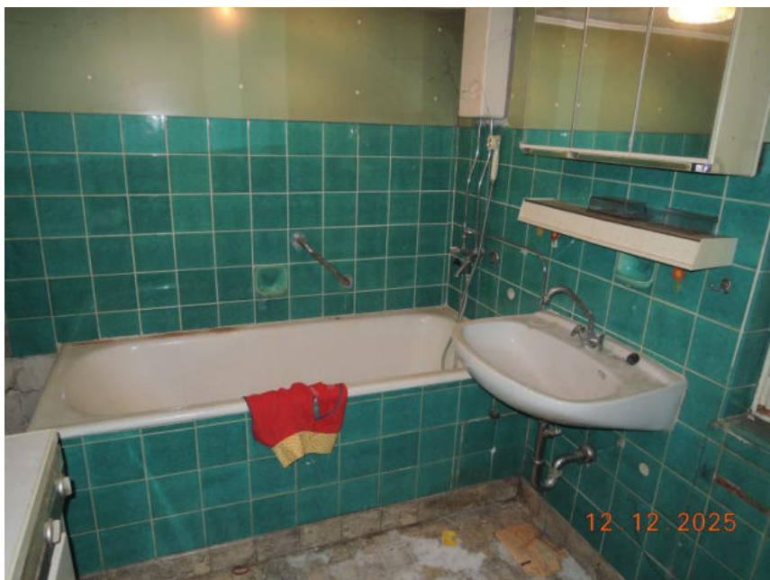
Bild 8: Bad im Erdgeschoss
