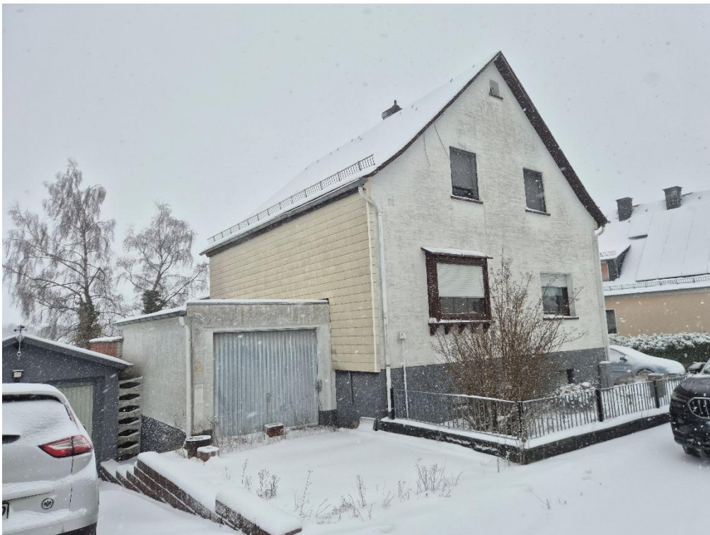
Beschreibung:02 Wohngebäude mit Garage
