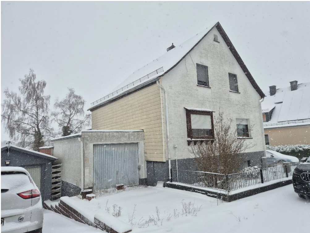
Beschreibung:02 Wohngebäude mit Garage
