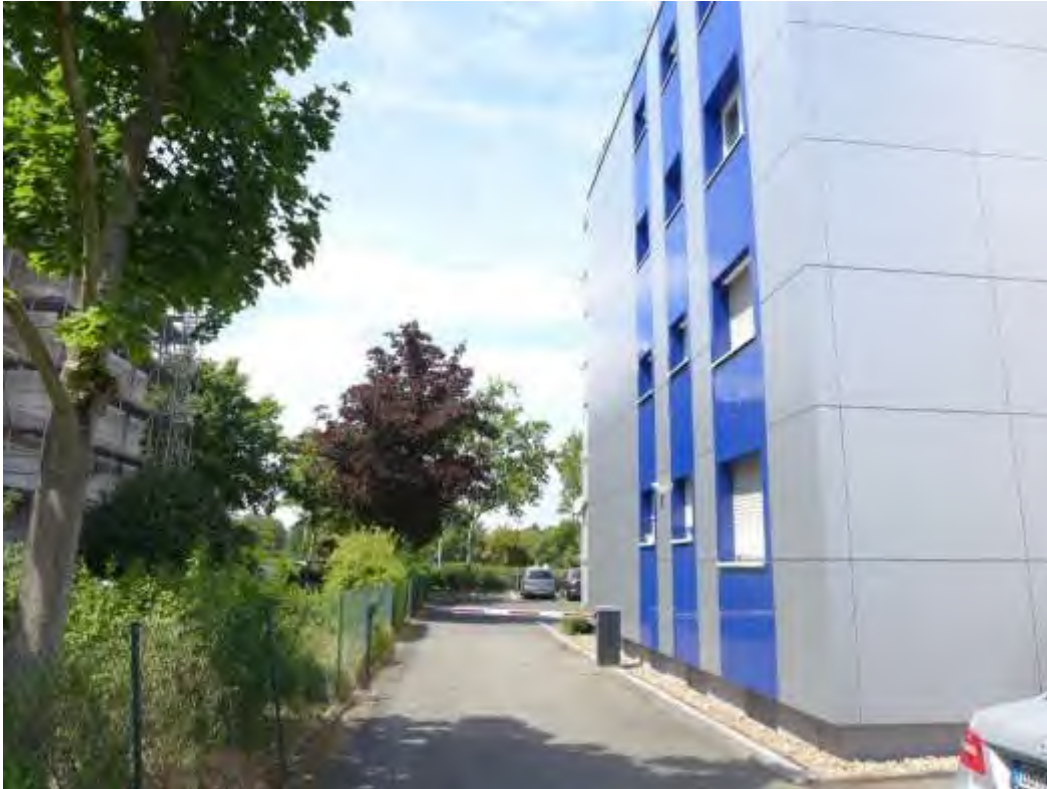
5 Seitenansicht, Zufahrt zur hinteren Stellplatzfläche
