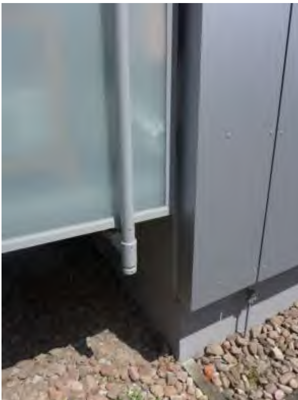
14 Detail erneuerte Fassade und Balkon
