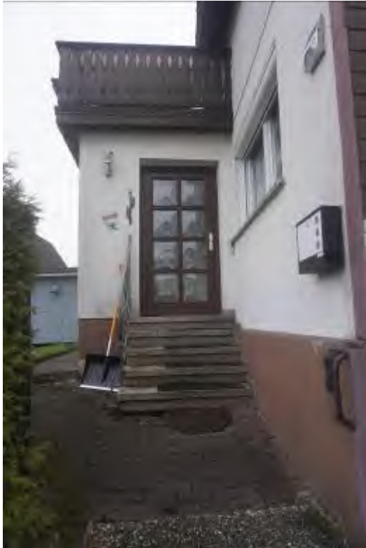
Hauseingang mit Loggia im Dachgeschoss
