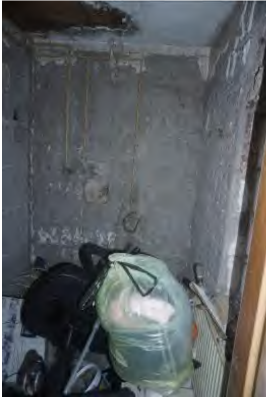
Nicht ausgebauter WC-Raum Dachgeschoss
