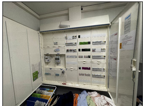
Kellergeschoss – Elektrounterverteilung
