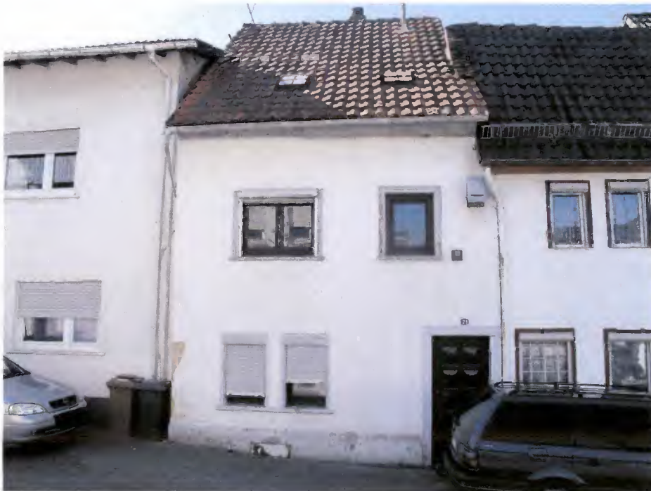
Foto Nr. 04: Ansicht von Straße Alter Markt Blickrichtung Süden
