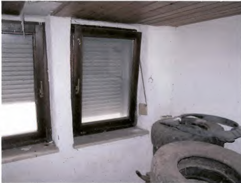
Foto Nr. 13: EG, straßenseitiger Wohnraum
