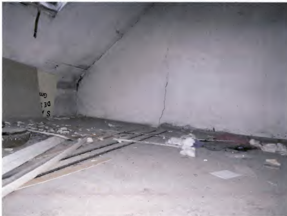
Foto Nr. 20: DG, wohnraumähnlich ausgebauter Raum
