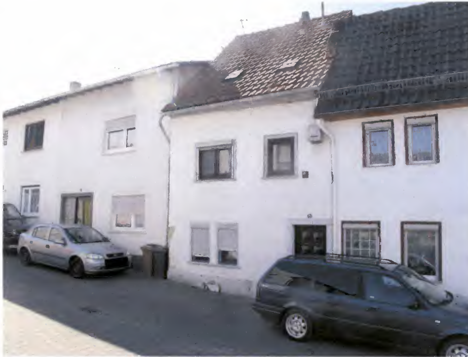
Foto Nr. 05: Ansicht von Straße Alter Markt Blickrichtung Süd-Osten
