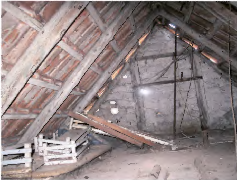
Foto Nr. 21: Dachboden
