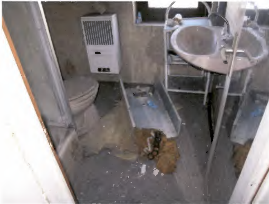
Foto Nr. 17: OG, Bad
