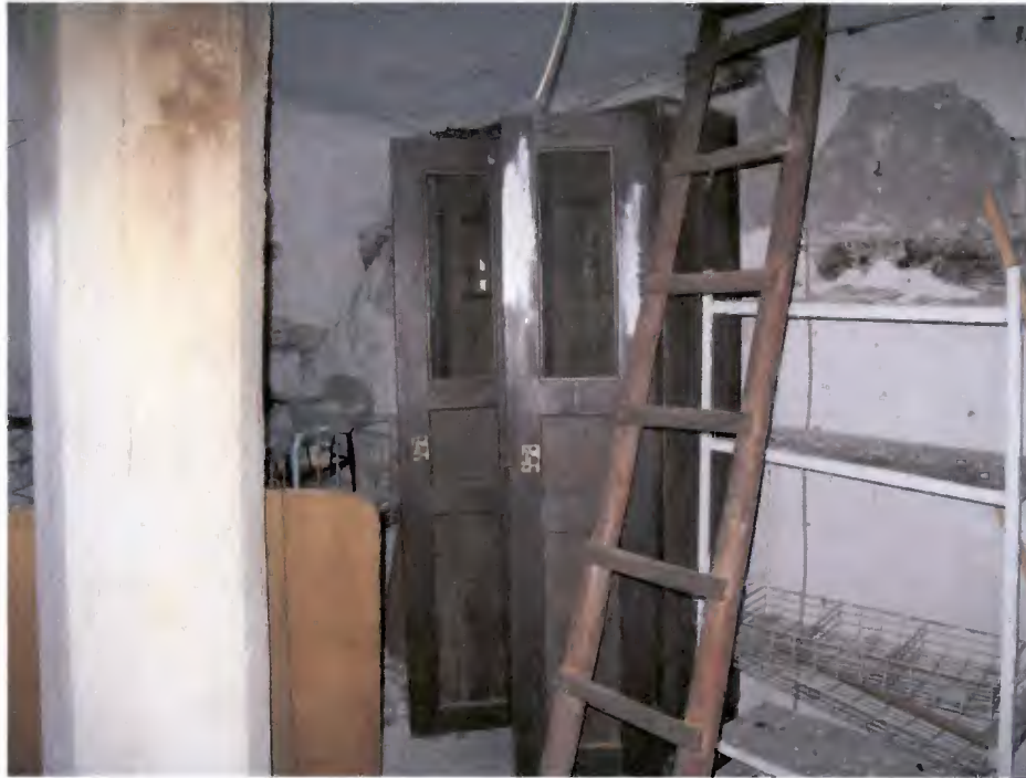
Foto Nr. 19: DG, wohnraumähnlich ausgebauter Raum
