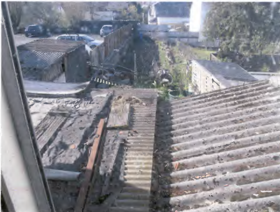
Foto Nr. 22: OG, Blick aus Fenster des gartenseitigen Wohnraums auf Flurstück 82/2 mit Fortsatz nach Westen (rechter oberer Bildrand)
