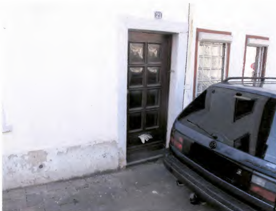
Foto Nr. 07: Hauseingang
