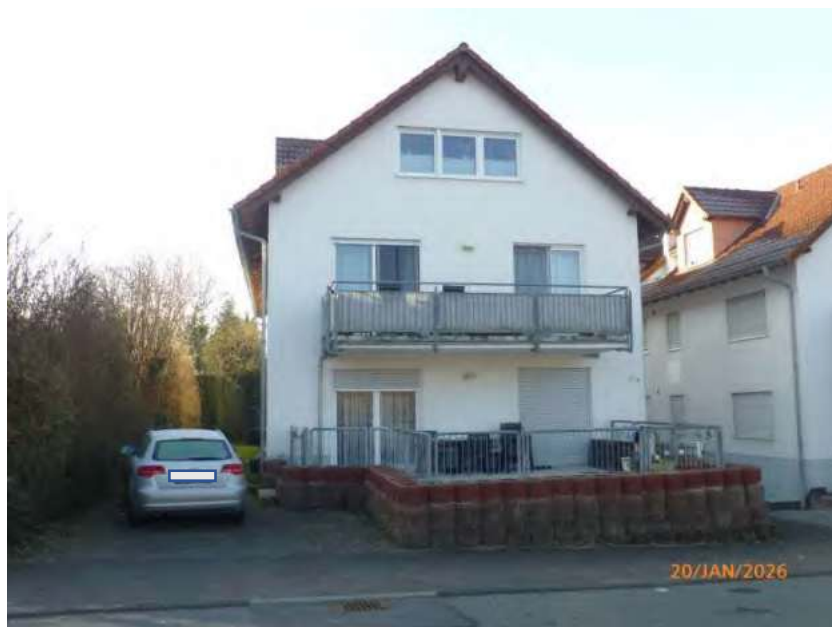
Ansicht von Nord-Osten, Straßenseite
