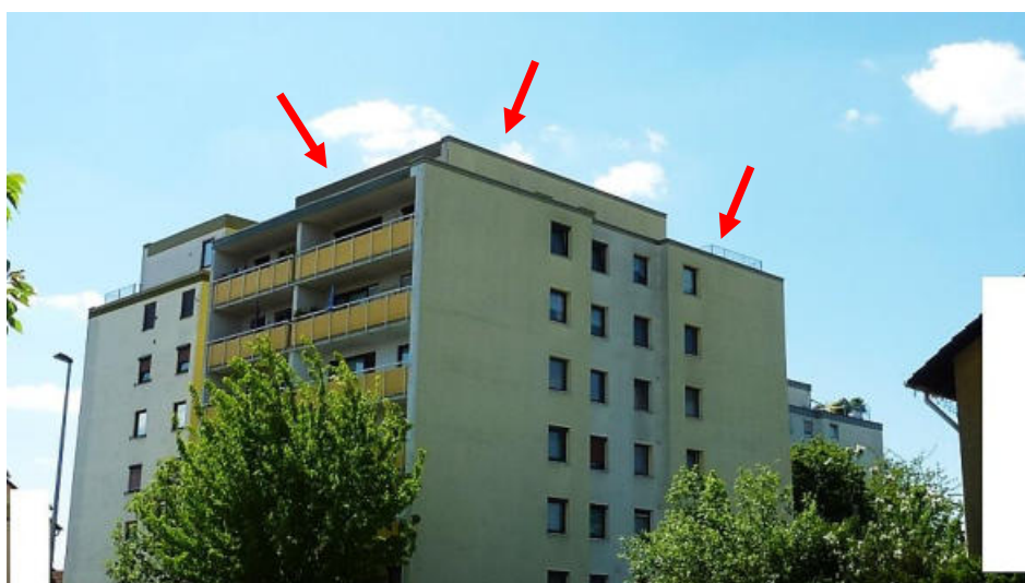
Straßen- / rechte Seitenansicht (Wohnung im 6.OG)
