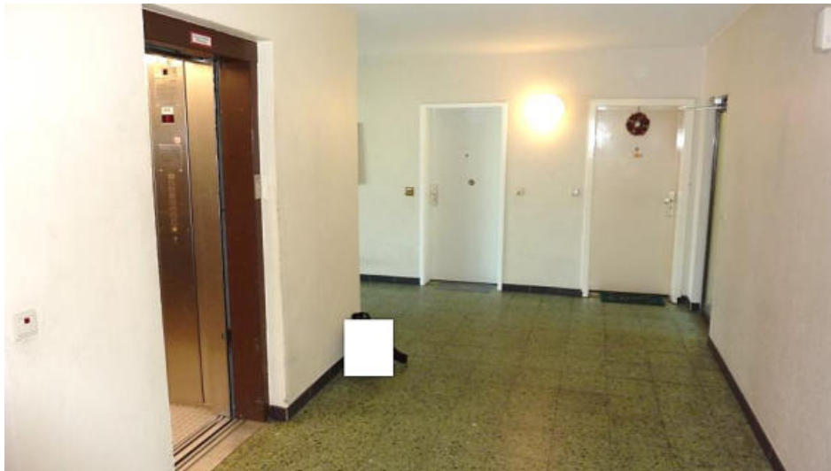
Hauseingangsbereich im EG mit Personenaufzug
