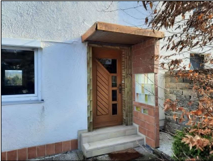
Abb. 7: Hauseingang auf Gebäuderückseite
