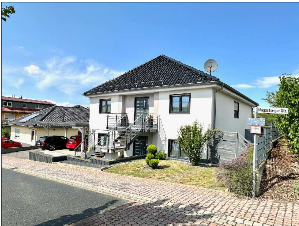
Foto 2 Ansicht von Süd-Osten
