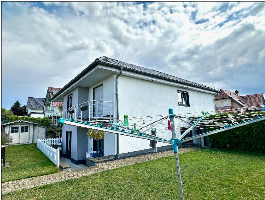
Foto 3 Ansicht von Westen
