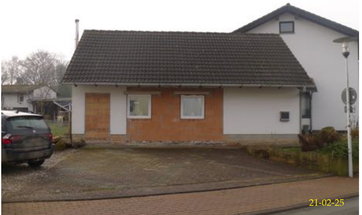
Wohnhaus W3 Ansicht von Norden
