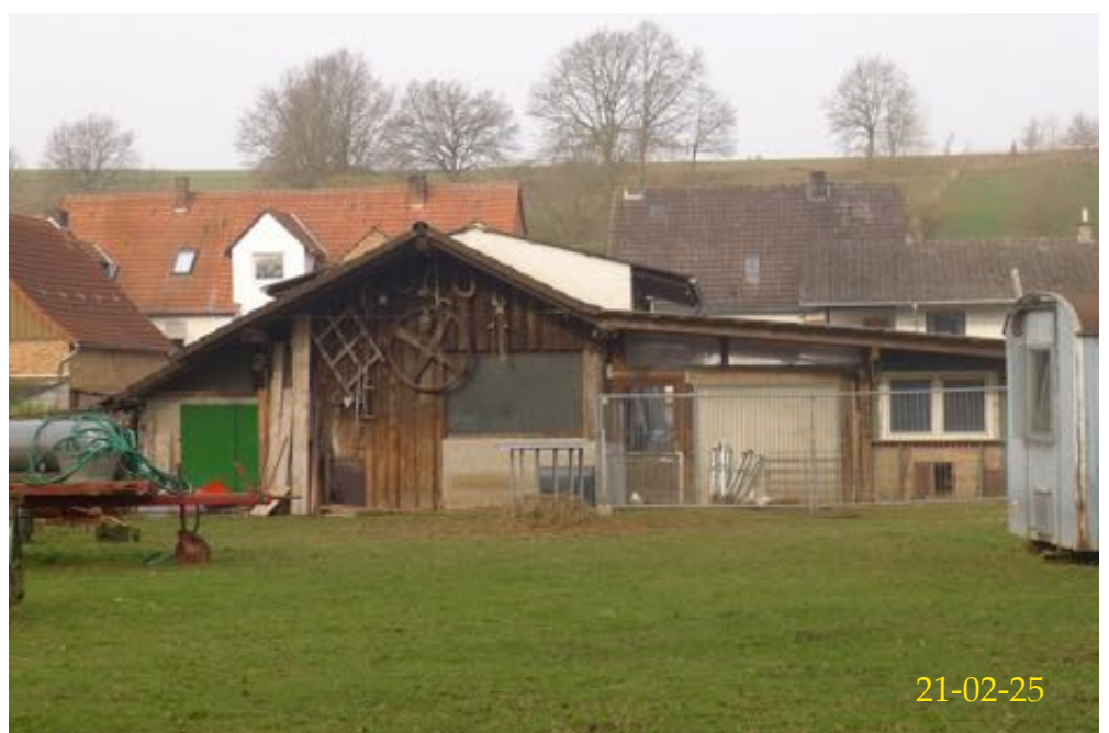
H) Holzschuppen Ansicht von Süd-Osten
