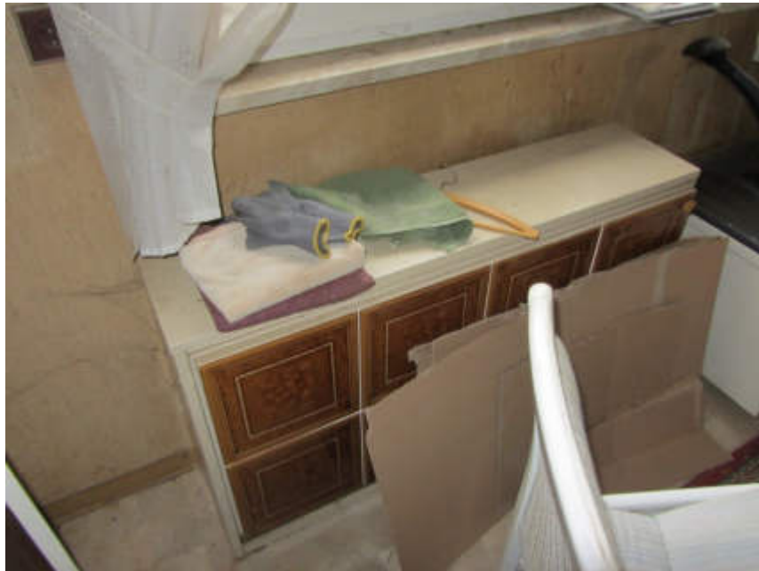
Bild 23: Elektr. Nachtspeicheröfen EG
