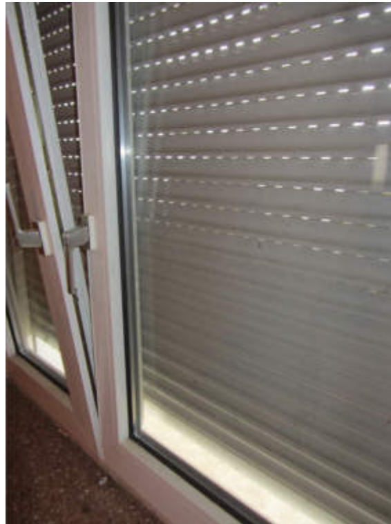
Bild 25: Zustand PVC- Rollläden vor Fenstern
