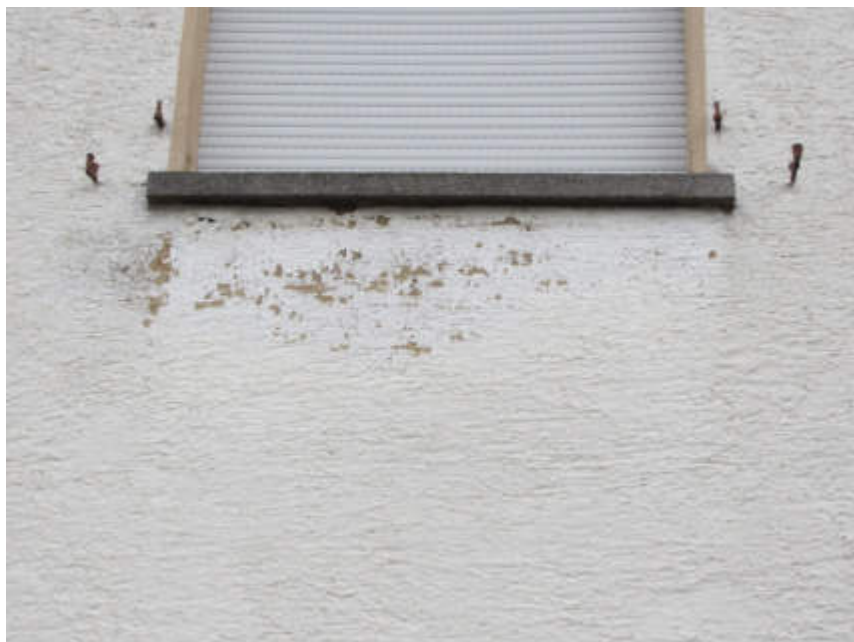
Bild 16: Putzschäden
