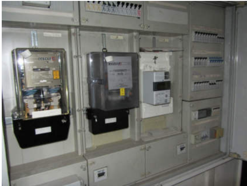
Bild 57: Stromzähler KG
