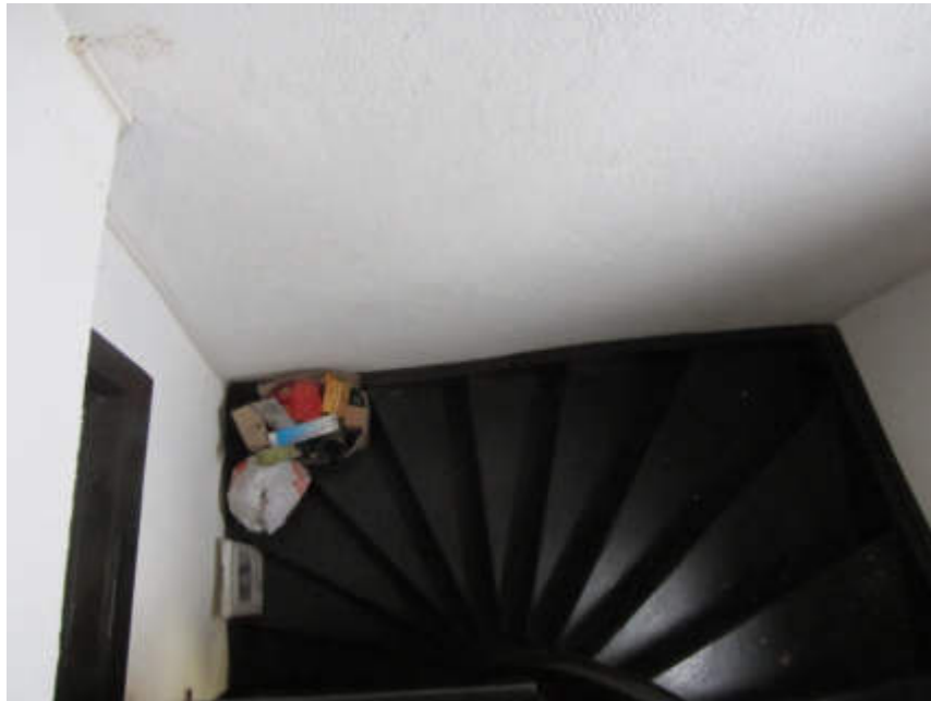
Bild 37: Treppe zu DG
