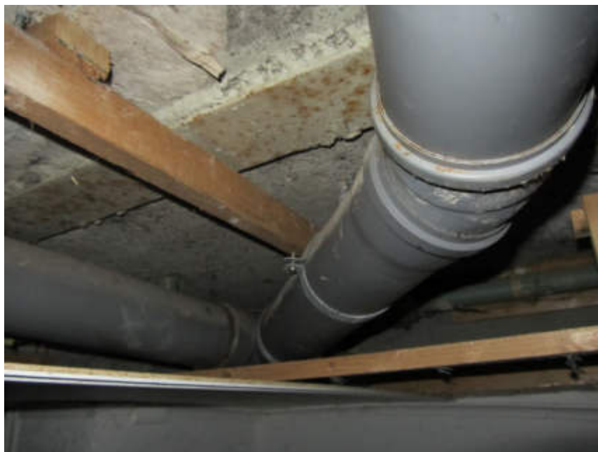
Bild 52: Abwasserrohre/ Wasserschaden
