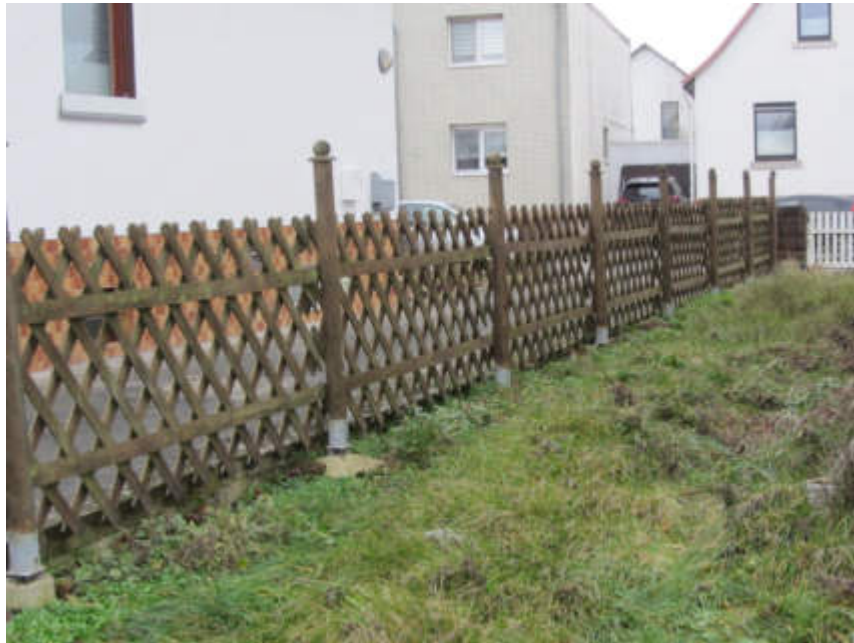
Bild 13: Einfriedung Jägerzaun (Holz)
