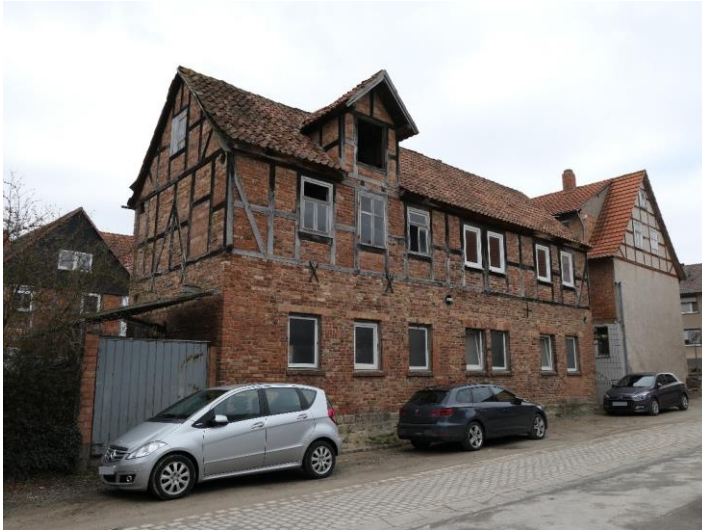
Bild 1 | Ansicht von Osten Nebengebäude aus Sicht der Straße Mittelgasse
