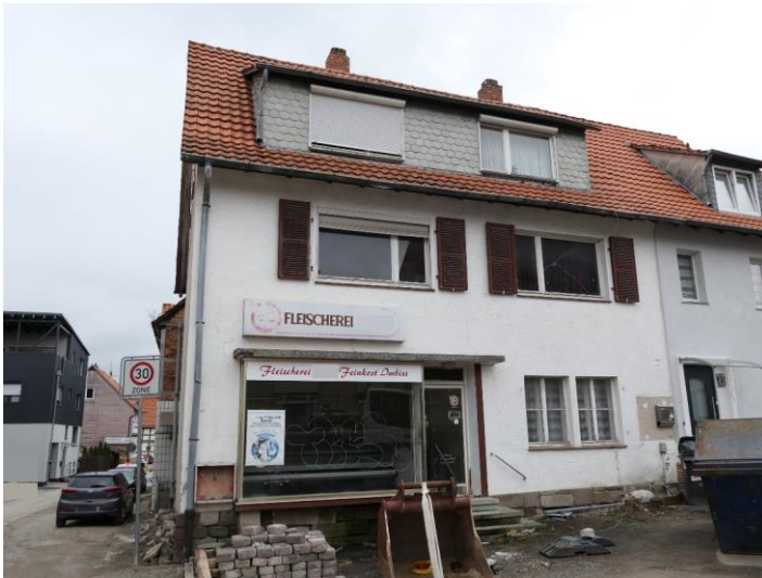
Bild 2 | Ansicht von Westen Wohn- und Geschäftshaus Wilhelmsthaler Straße
