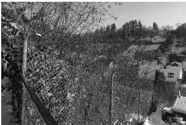
8.1.11 Grundstück an der südwestlichen Grundstücksecke, Blick Richtung Nordosten
