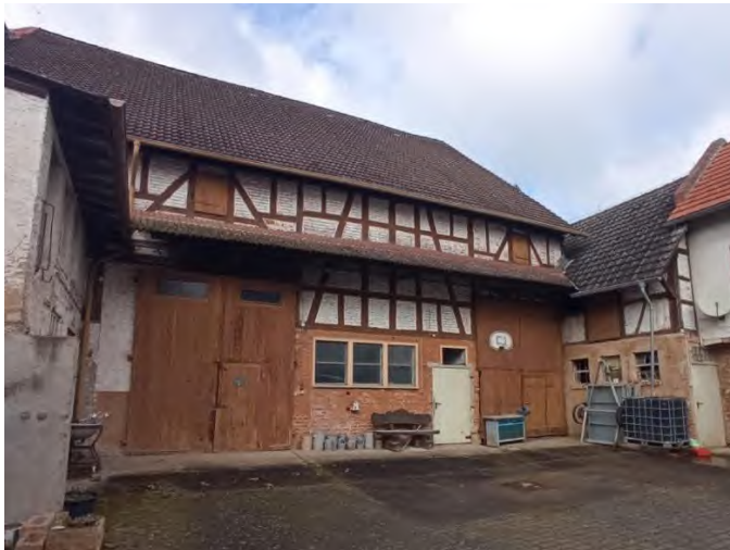
10 – Scheune / Stall Hofseite
