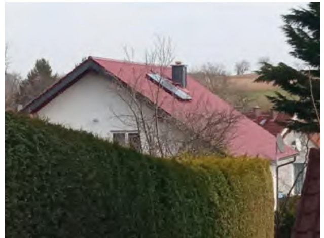
09 – Solarmodule auf Südostseite
