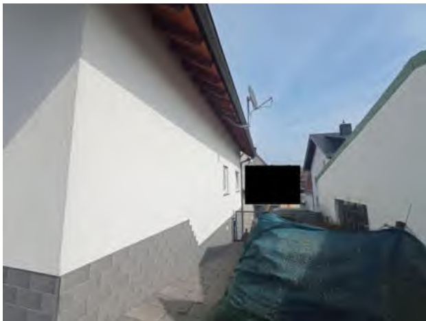
10 – Nachbarseite / von Süden
