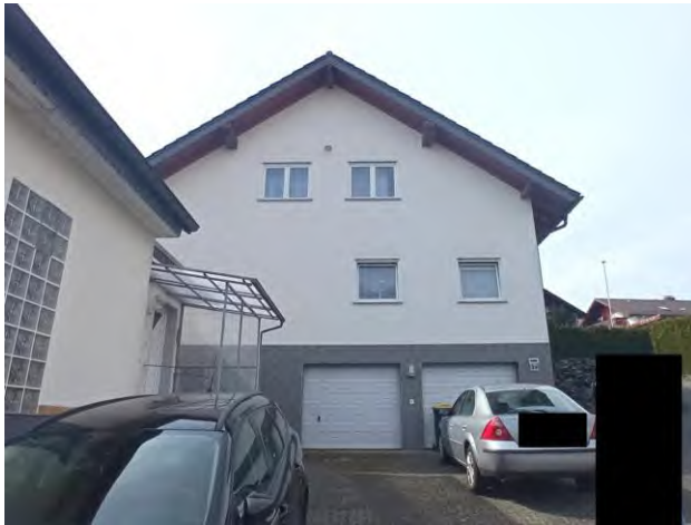
Straßenseite von Nordosten
