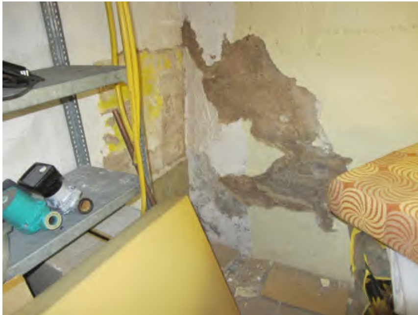
Bild 37: feuchte Kellerwände
