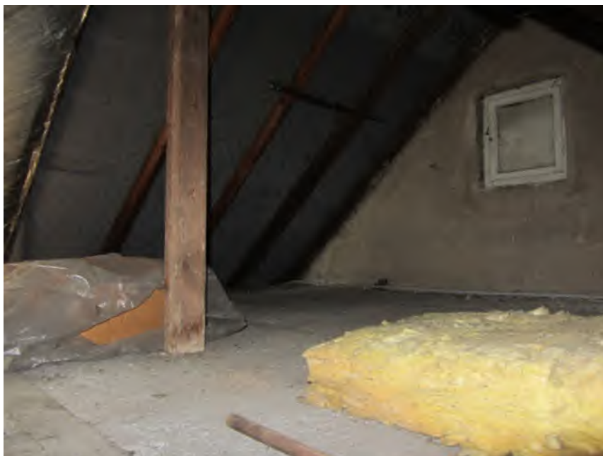
Bild 52: nicht ausgebauter DG-Bereich/ Spitzboden
