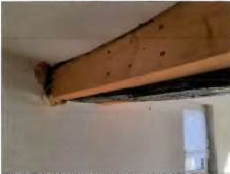
Abb. 16: Zimmer Erdgeschoss, verstärkter Deckenbalken
