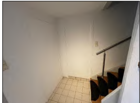
Zugang 2. Wohneinheit Wohnhaus
