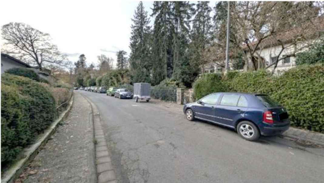
Bild A2 Blick in die Erschließungsstraße
