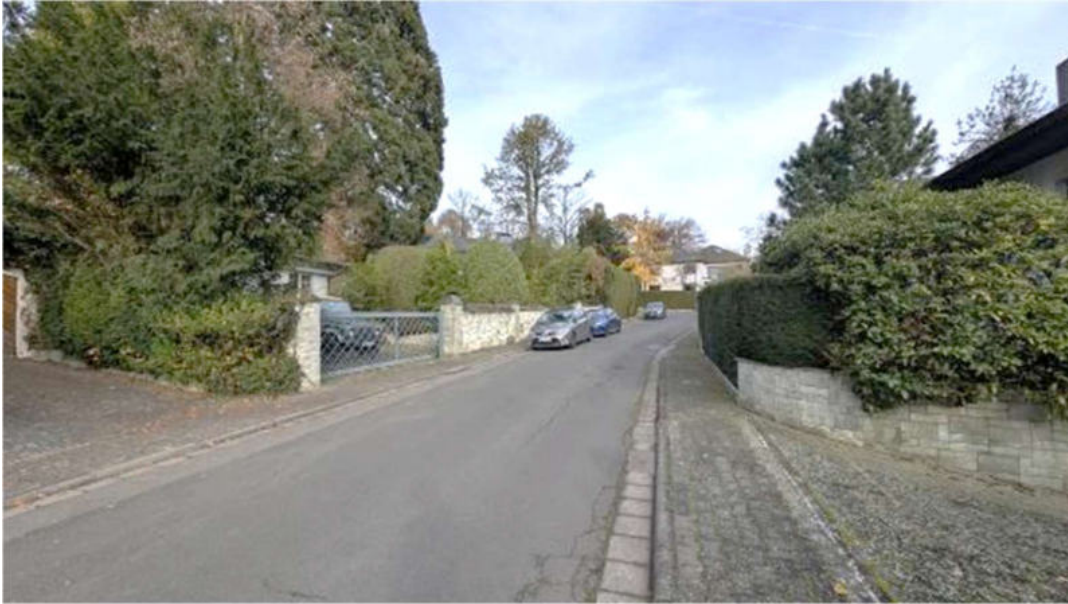
Bild A1 Blick in die Erschließungsstraße
