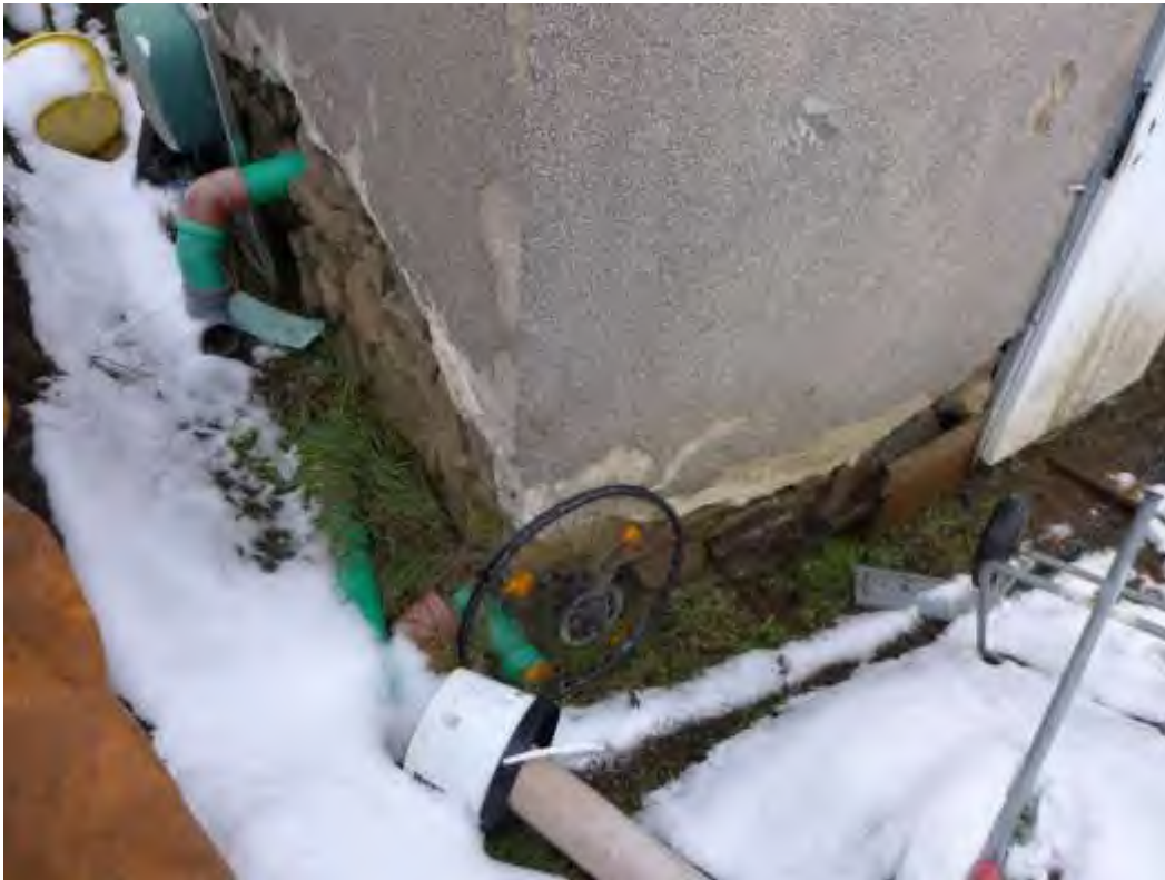
13 Fassadendetail unterer Eckbereich
