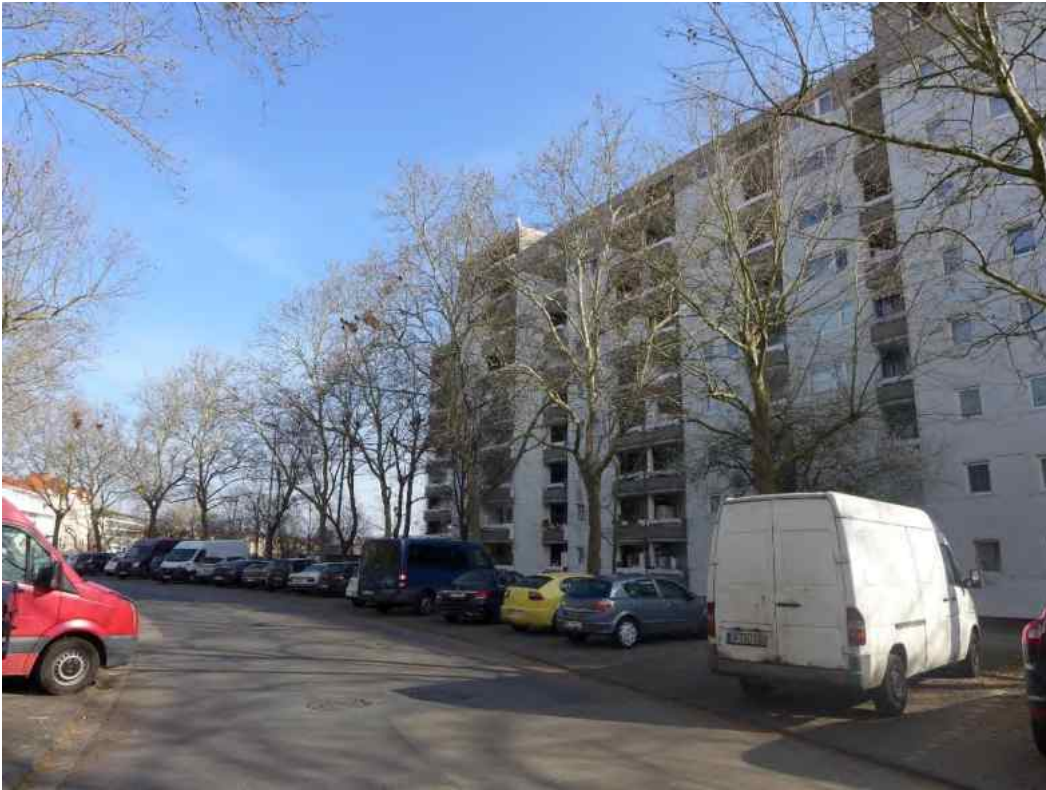
1 Straßenansicht Gebäude Wertheimer Weg 2-4
